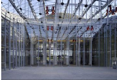
Figure 76: vue de l'espace
