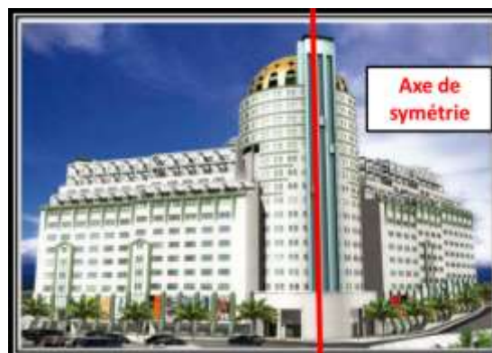
Figure 48: La façade symétrique du centre multifonctionnel de Cheraga. Source : http://bib.univ-oeb.dz
