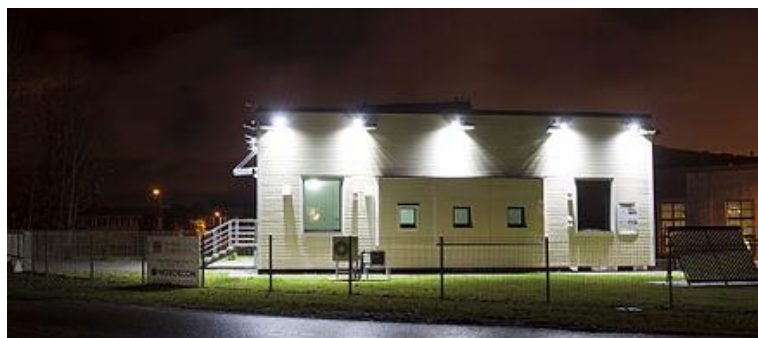
Figure 3: Bâtiment d'essai zéro énergie à Tallinn source: www.stringfixer.com
