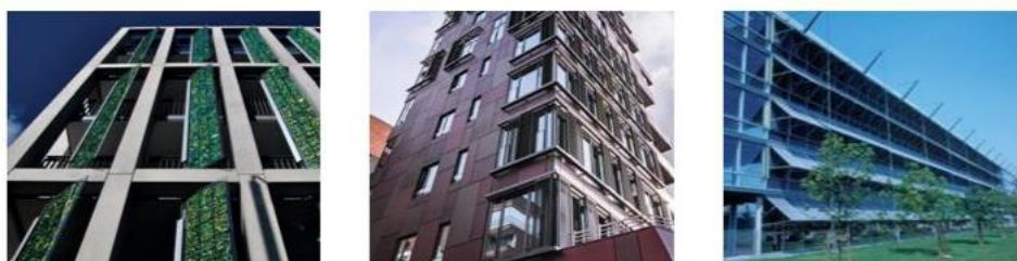
Figure 13: protection solaire extérieure source : www.colt-france.fr
