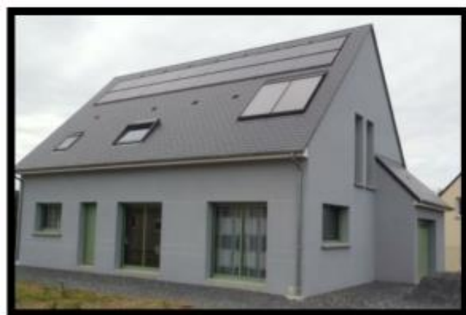
Figure 29: la maison de la manche source: www.observatoirebbc.org
