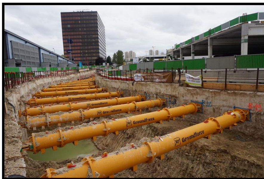
Figure III.11 : Des butons hydrauliques.
