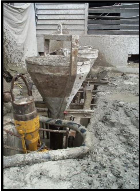
Figure II.18 : Deux tubes-plongeurs et pompage boue.
