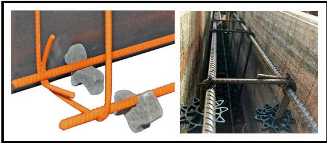
Figure II.12 : rouleaux et cales d'enrobage liaisonnées à la cage d'armature.
