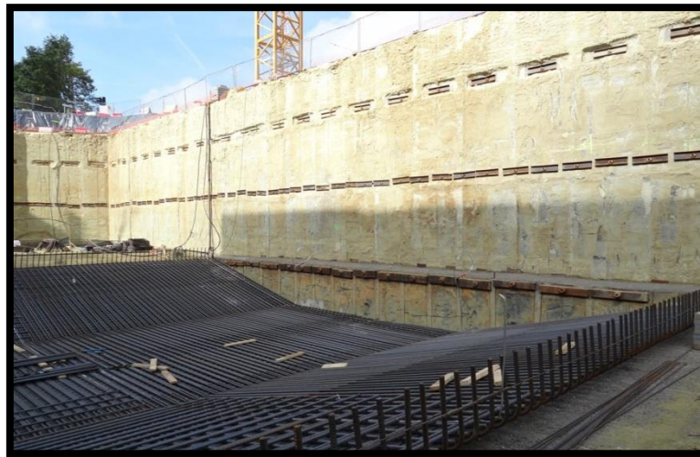
Figure I.10 : Les parois en soilmix.
