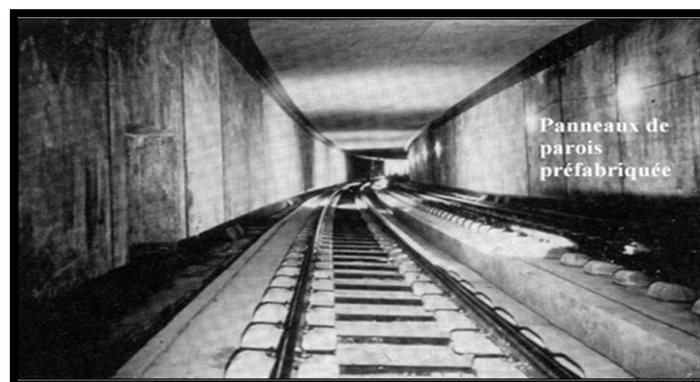
Figure II.28. Vue des piédroits formés des parois préfabriquées dans le tunnel SNCF gare du Nord-Roissy (France) [6].
