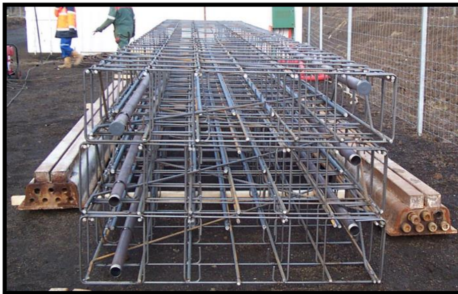
Figure II.11 : Cages d'armatures d'une paroi moulée.
