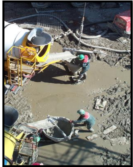
Figure II.19 : Bétonnage avec deux tubes plongeurs.
