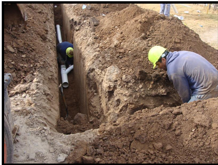
Figure II.35 : L'éboulement du terrain lors de l'excavation de paroi moulée.
