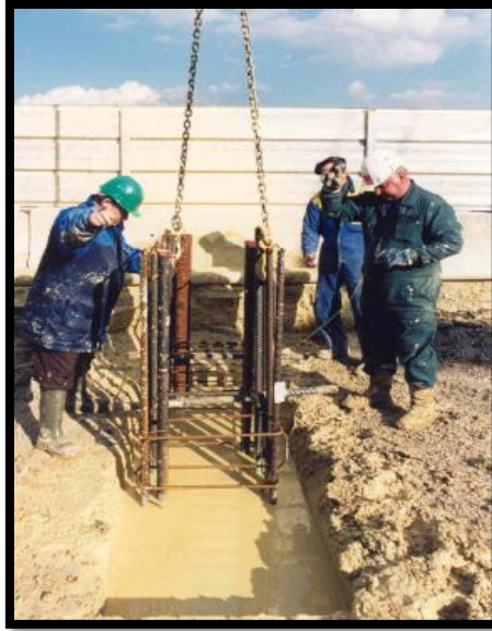
Figure II.16 : Réglage de la cage sur les murets-guides.
