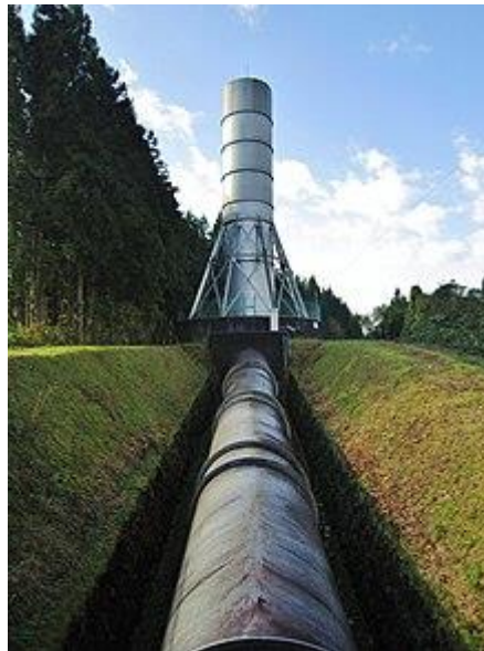
Fig. (5.19) : Photo d'une cheminée
