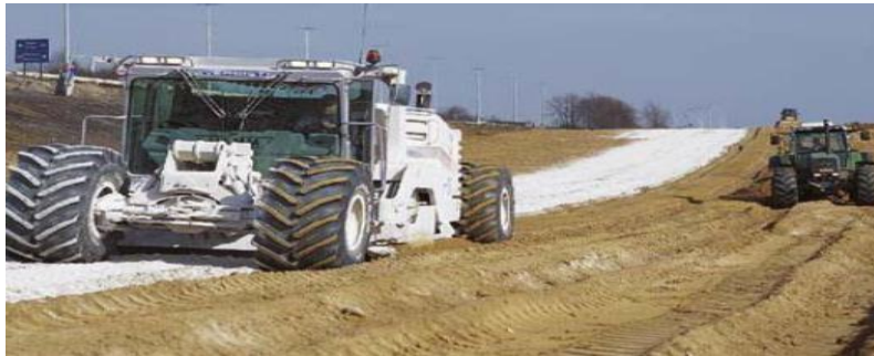
Fig. II.4 Traitement par malaxage
