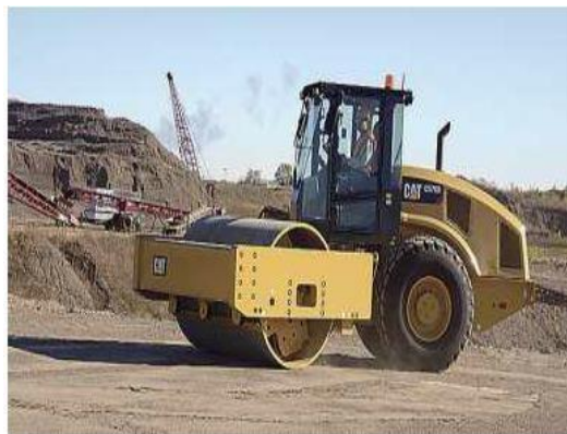
Compactage de Surface
