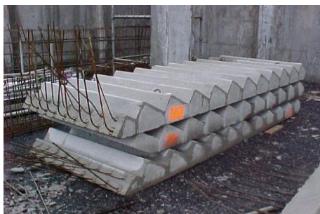
Figure 2.21 : Escalier préfabriqué en béton armé [10].
