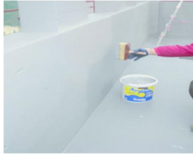
Figure 2.13 : Étanchéité liquide réalisée lors de la construction [11].
