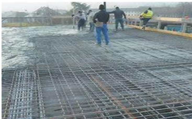
Figure 2.29 : Coulage d'un plancher en dalle pleine [15].
