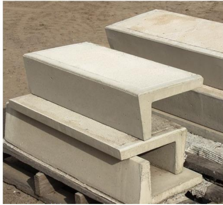
Figure 2.26 : Exemple d'élément d'un escalier préfabriqué à marches indépendantes.
