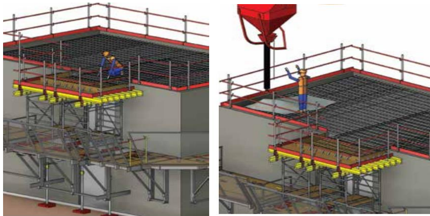
Figure 2.15 : a) Coffrage et ferrailage du balcon, b) Coulage du béton [11].
