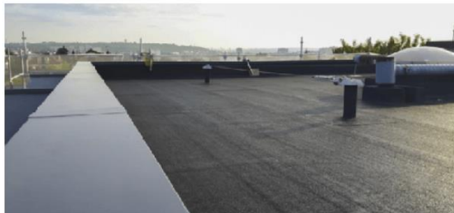
Figure 2.5 : Acrotère recouvert d'une couvertine [2].
