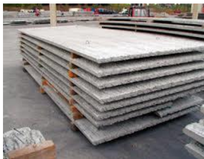
Figure 2.28 : Stockage des prédalles [15].
