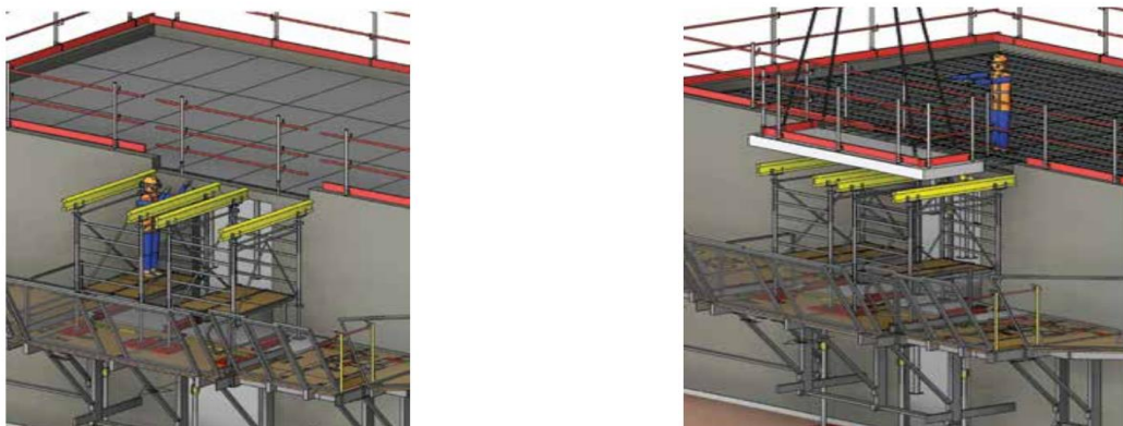
Figure 2.17 : a) Mise en place de l'étalement, b) Pose du balcon (avec garde-corps intégrés [4].
