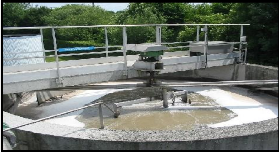
Figure 3: Mécanisme du dégrillage et dégraissage [4].
