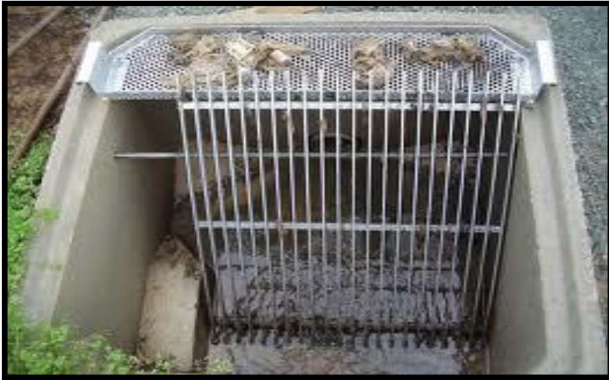
Figure 2: Mécanisme du dégrillage [3].
