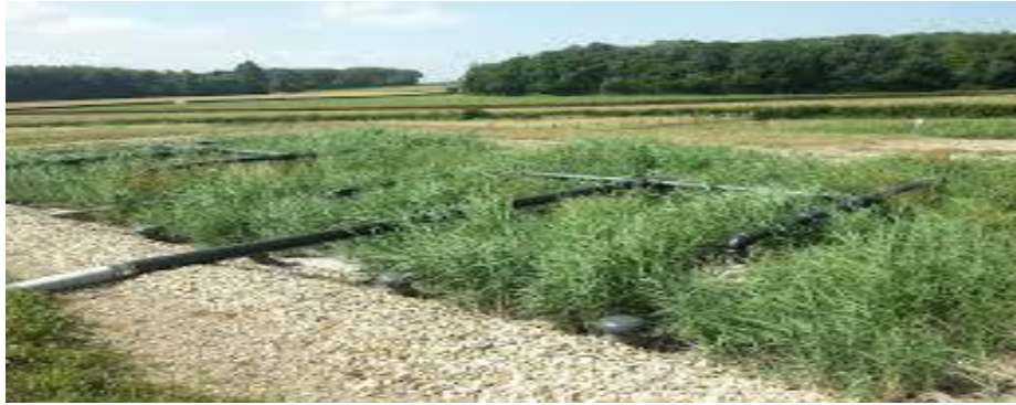
Figure 6-9 : filtres plantés de roseaux
