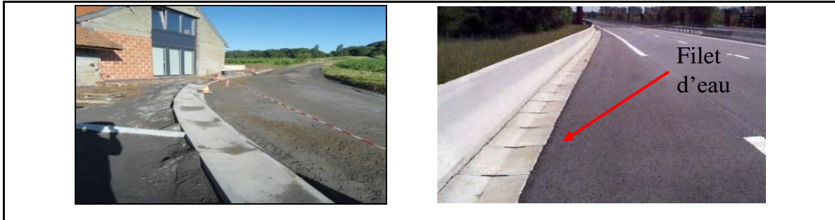
Photo 2.2 : Filet d'eau en béton [8].
