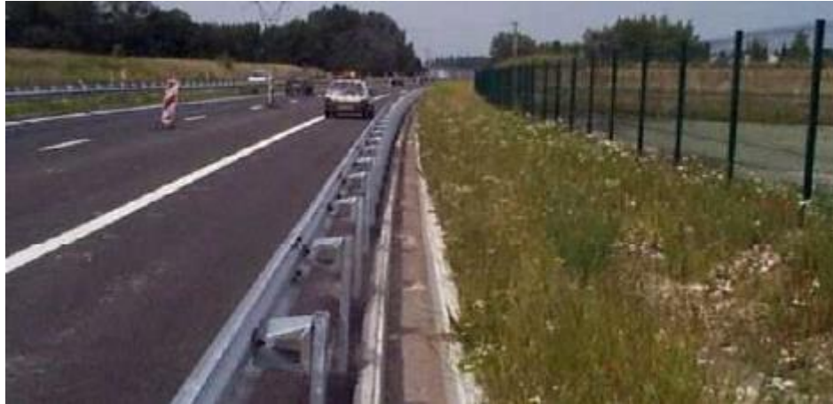
Photo 1.3 : Caniveau rectangulaire placé derrière la glissière [4].
