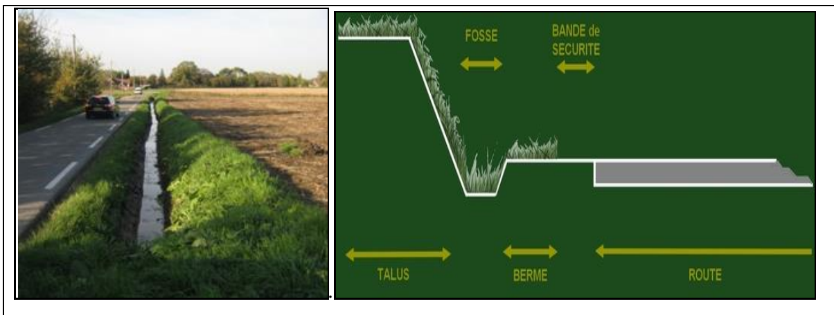
Photo 2.1 : Image d'un Fossé
