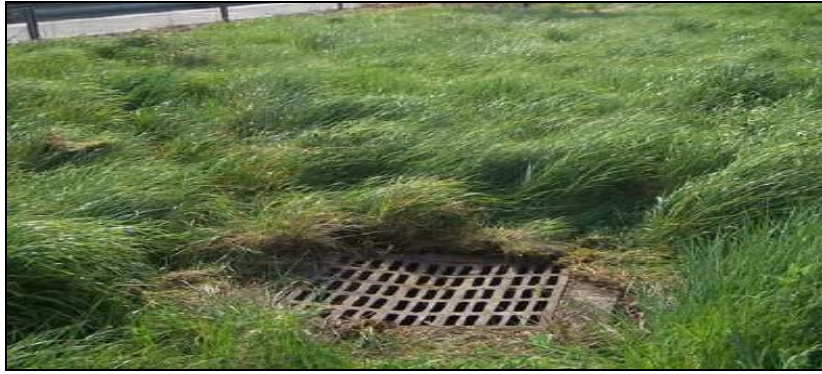
Photo 1.2 : Cunette engazonnée associée à une canalisation en pied de talus de déblai [4].
