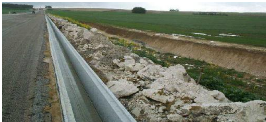
Photo 1.4 : Caniveau rectangulaire coulé en place avant la réalisation de la chaussée [4].
