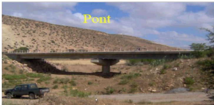
Photo 2.7 : Ouvrage de franchissement : le pont.
