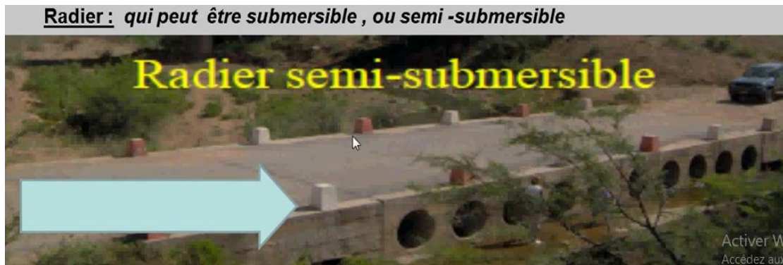
Photo 2.6 : Radier semi-submersible.
