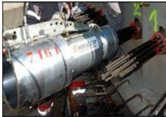
c) Mise en tension des câbles à l'aide de vérin
