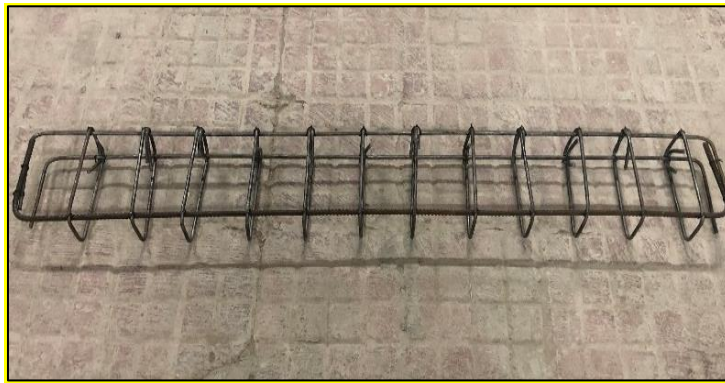
Figure II.25 : Schéma réel du ferrailage de la poutre.
