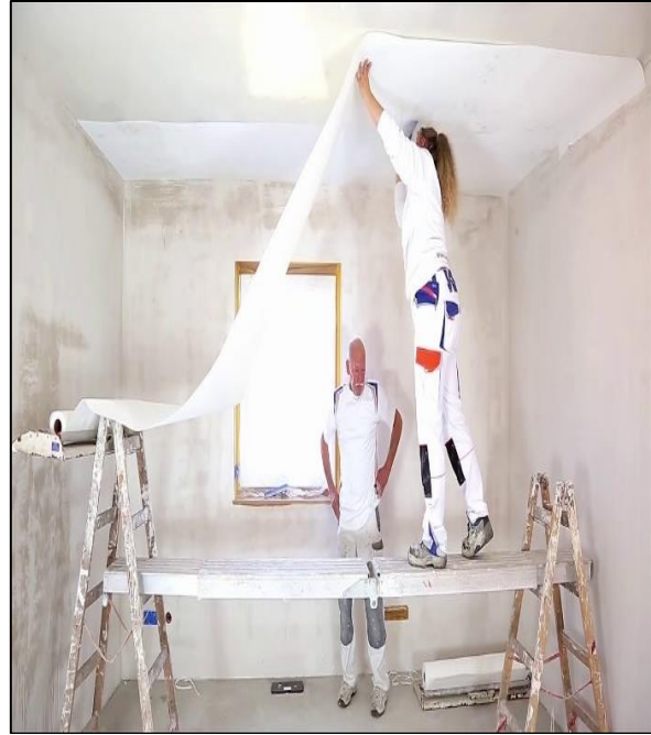
Figure I.20 : Renforcement en flexion d'une dalle par de mat de verre [33].
