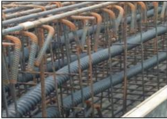
a) Mise en place de gain
