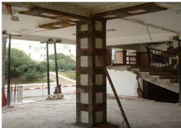
Figure I.11 : Chemisage en acier d'un poteau.
