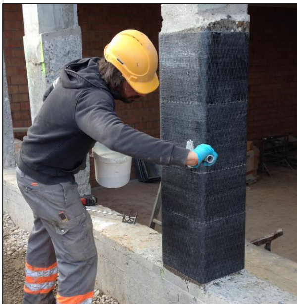
Figure I.21 : Renforcement par confinement d'un Poteau par des fibres de carbone [34].
