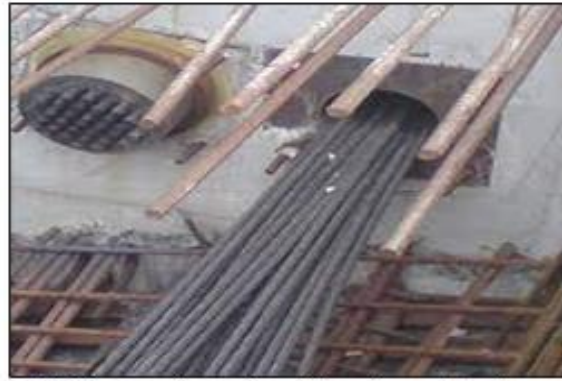
b) Mise en place des câbles de post tension
