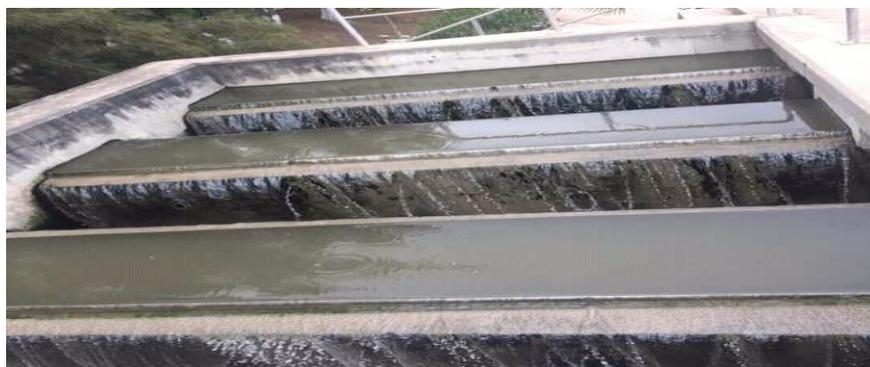
**Figure 4:** Etape de Dégraissage de la STEP(prise personnelle).
