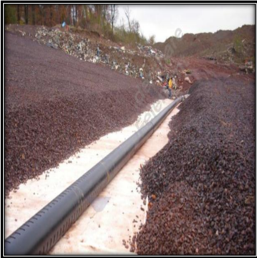
Figure 7: Réseau de drainage (GIZ ,2016)
