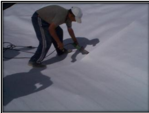
f) La soudure du géotextile
