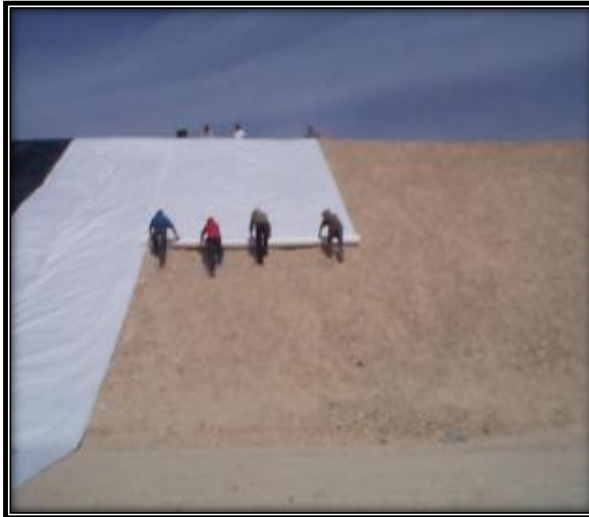
d) Pose de géotextile
