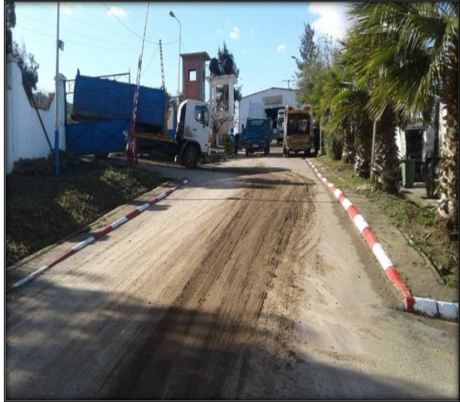
Figure 18 : Poste de contrôle
