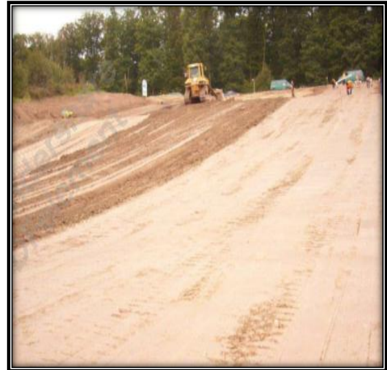
b) Décapage de la terre végétale
