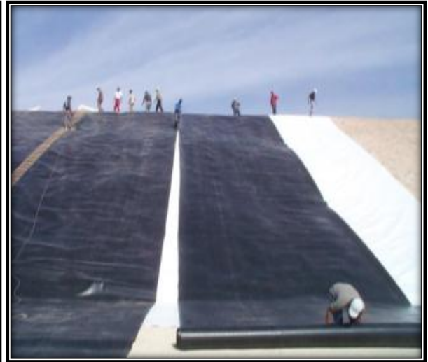
e) Pose de géotextile
