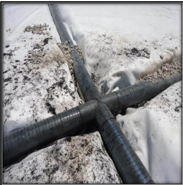
Figure 9 : Collecte de lixiviats (drains verticaux) (Bouterfa, 2018)
