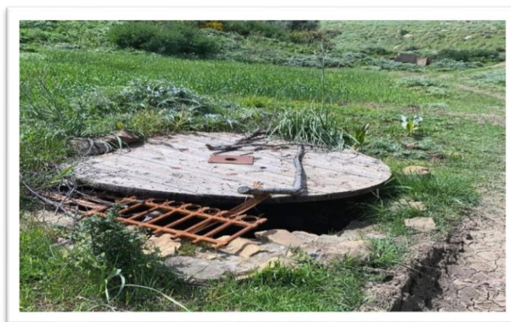
Figure 09 : Photo présentant le Puits « Boukerdime Ettayeb (P1) ».
