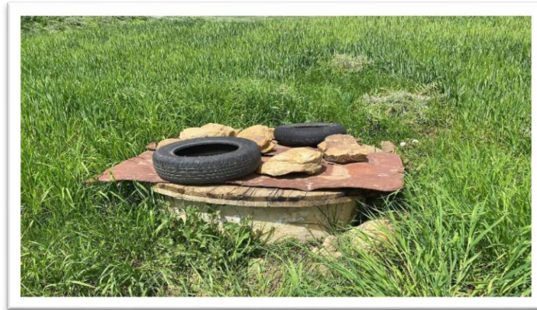
Figure 10 : Photo présentant le Puits « El Aggoune Idriss (P2) ».
