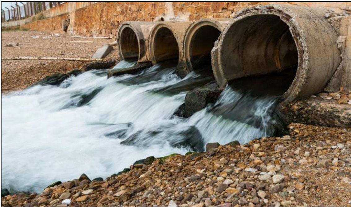
Figure 1: Les eaux usées [1]
