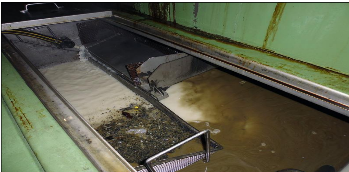
Figure 4: Mécanisme de dessablage / dégraissage. [4]
