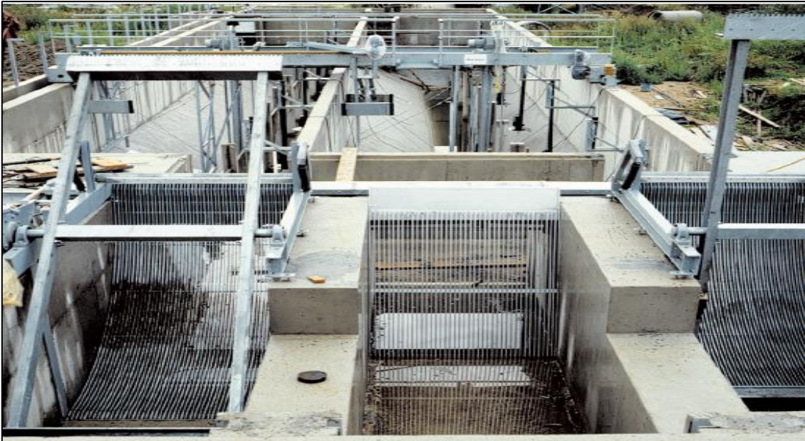
Figure 3: Mécanisme de dégrillage. [3]
