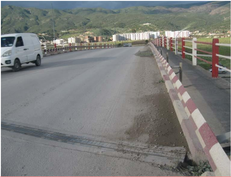
Figure A.1 VUE GENERALE AU DESSUS DE L'OUVRAGE : Ouvrage situé dans une zone suburbaine
