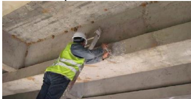
Figure IV-12 : Poutre centrale Côté amont
