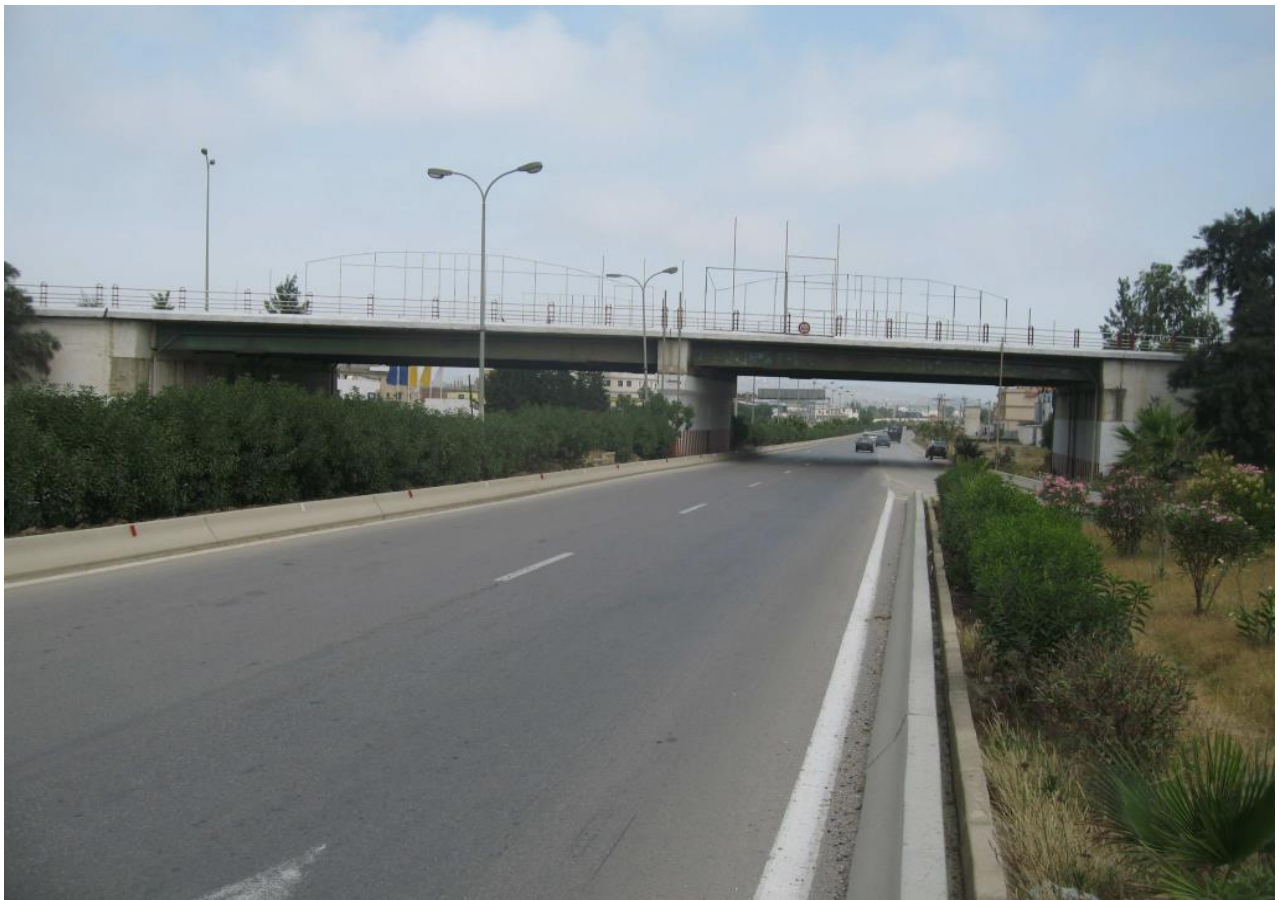
Figure IV-10 : Vue générale Pont échangeur RN 44 PK 6+400
