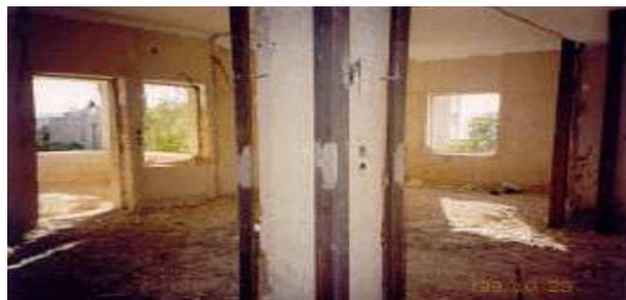
Figure III-7 : Renforcement De Poteaux Au Moyen De Profiles Métallique
