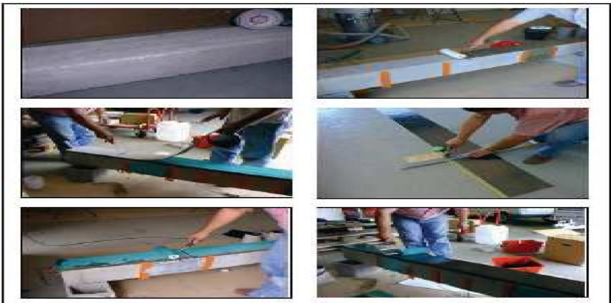
Figure III-5 : Mise En Œuvre Par Stratification Directe
