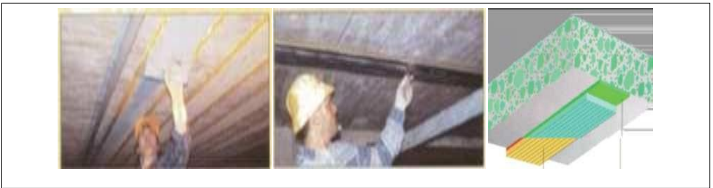
Figure III-6 : Procède Par Collage De Plaques (SIKA, 1996)
