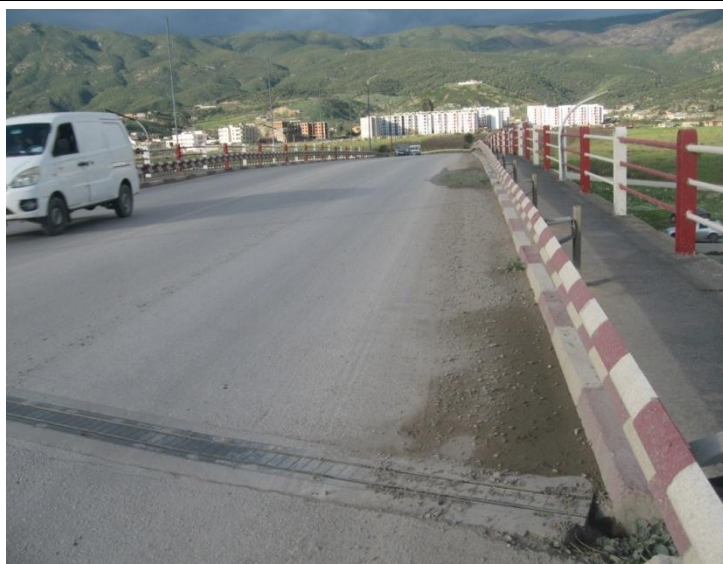
Figure IV-2 : Vue au-dessus de l'ouvrage
