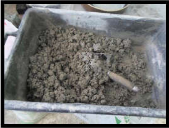
Figure 5.8: Gachée du mortier.
