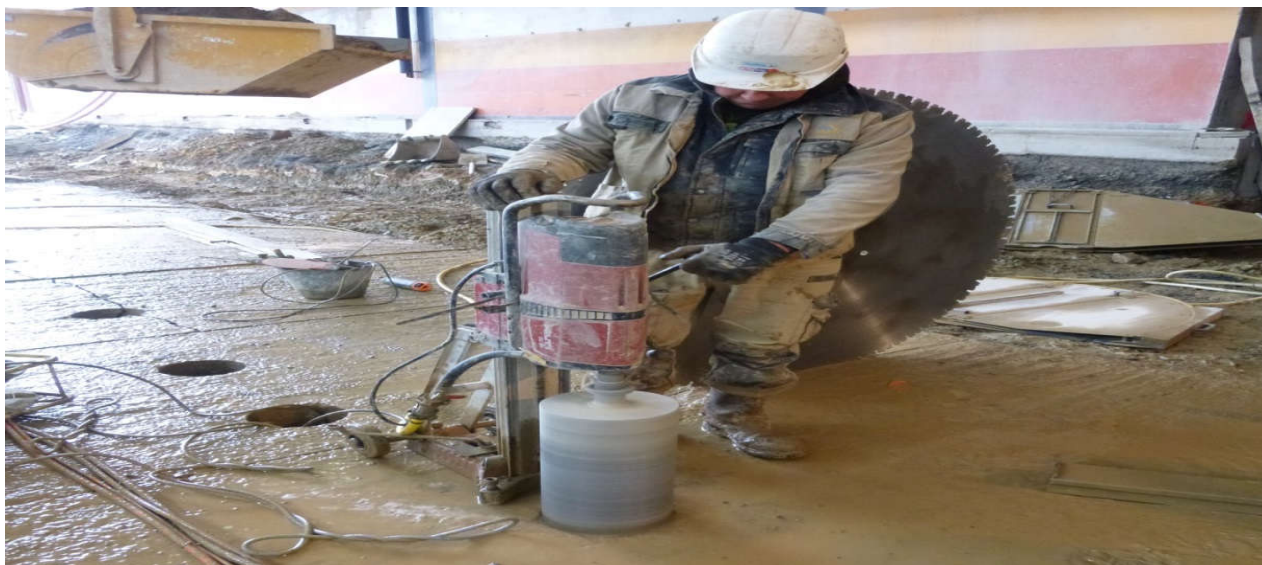
Figure 3.8 : essais de carottage verticale.
