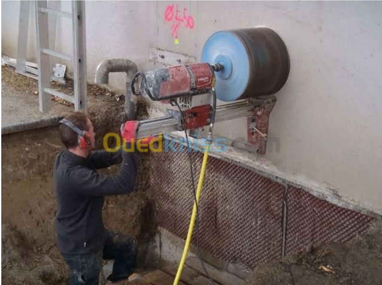
Figure 3.9 : essais de carottage horizontal.
