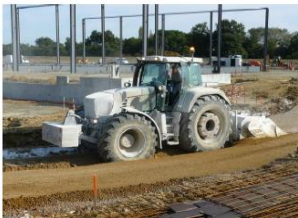
Figure 56: Malaxage du liant avec le sol
