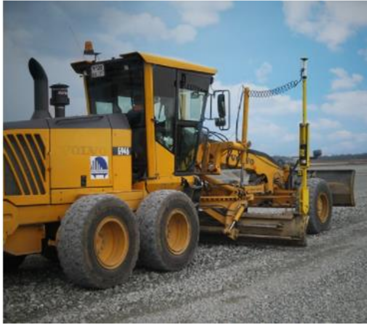
Figure 58: Réglage d'une couche compactée avec niveleuse
