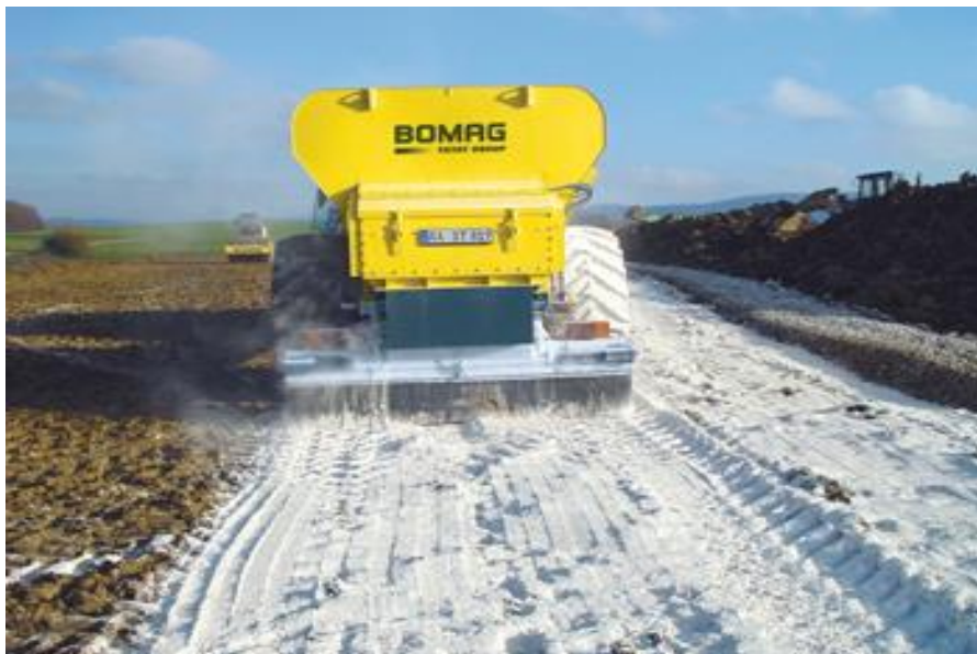
Figure 54: Epannage de liant
