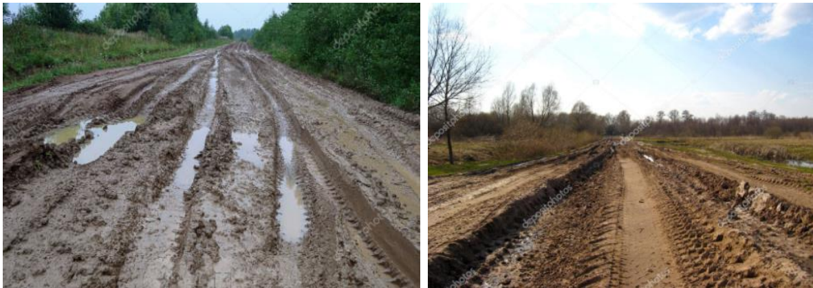
Figure 20: Difficulté de la traficabilité des engins sur les sols fins
