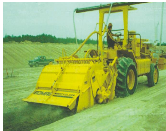
Figure 56: Malaxage du liant avec le sol
