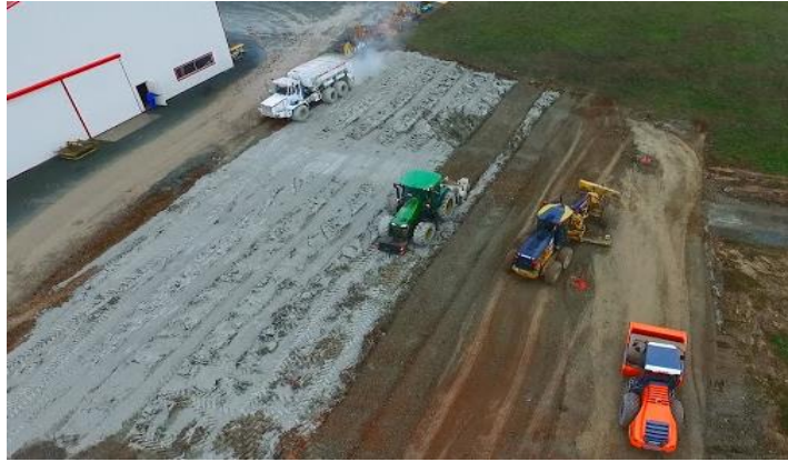
Figure 25: Traitement des sols aux liants hydrauliques
