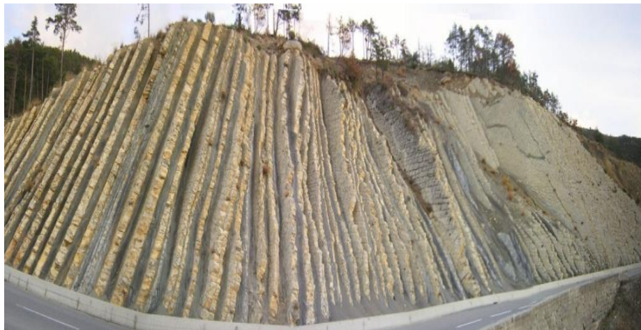
Figure 15: Talus de déblais routier – alternance marno-calcaire
