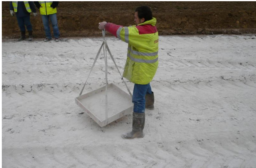
Figure 55: Contrôle de l'épandage: pesée de l'agent de traitement épandu sur un plateau en aluminium
