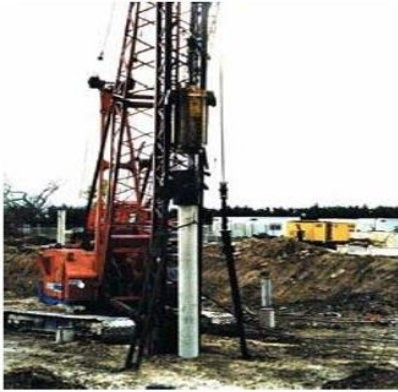
Figure II-15 : Pieux moulés par battage du tube [H]
