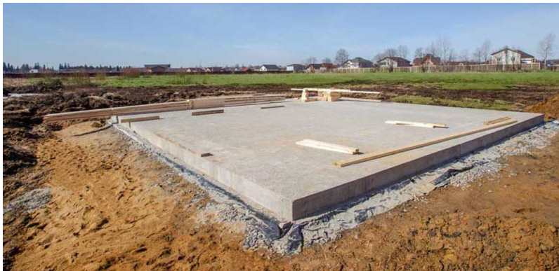
Figure II-8 : Photo d'un radier générale
