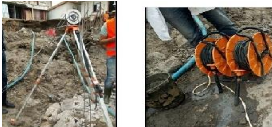
Figure II-29 : Treuil de mesure de la profondeur et tourets de câbles [11]
