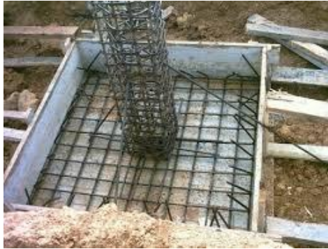
Figure V-2 : Exemple de ferrailage d'une semelle isolée
