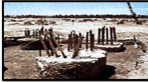
Figure II-30 : Têtes de pieux dégagées. On voit les armatures en attente pour être reliées aux cages d'armatures des semelles
