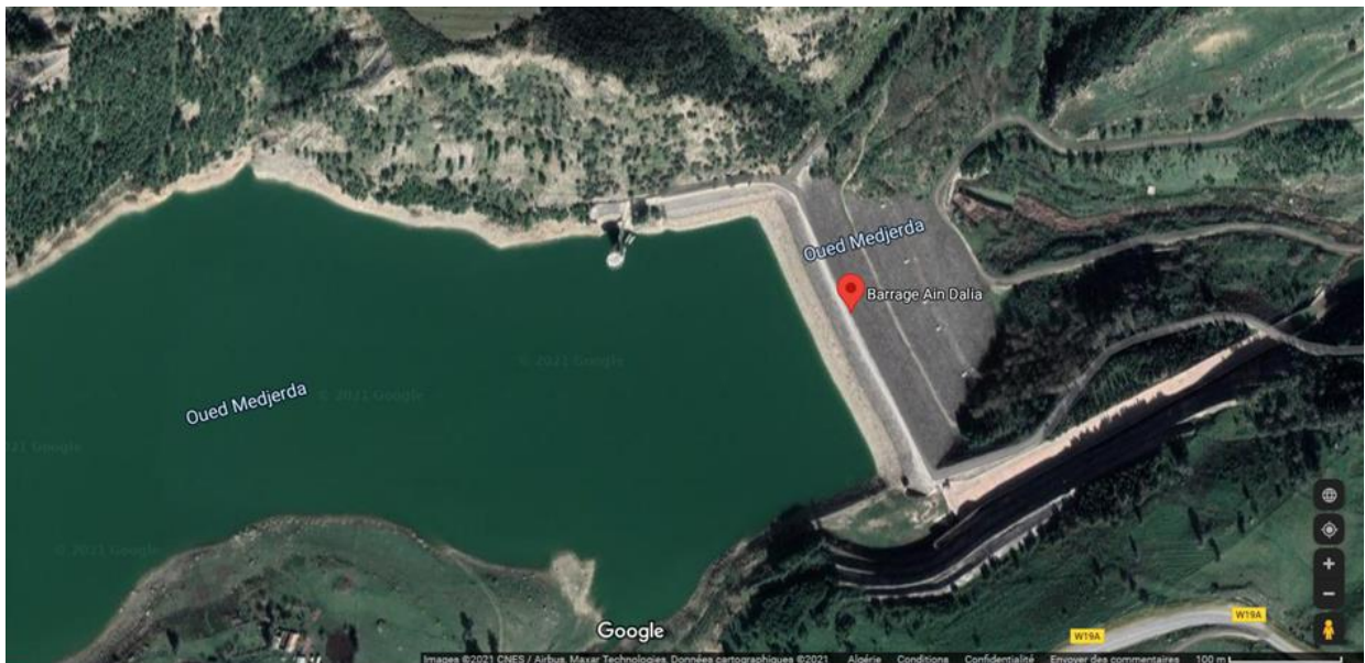
Figure 14 Vue géographique sur le barrage de Ain Dalia (wilaya de Souk Ahras)
