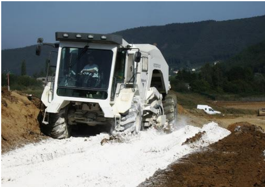
Figure 21 : Traitement des sols aux liants hydrauliques
