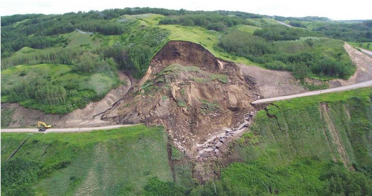
Figure 19 : Risque de glissement de talus naturels
