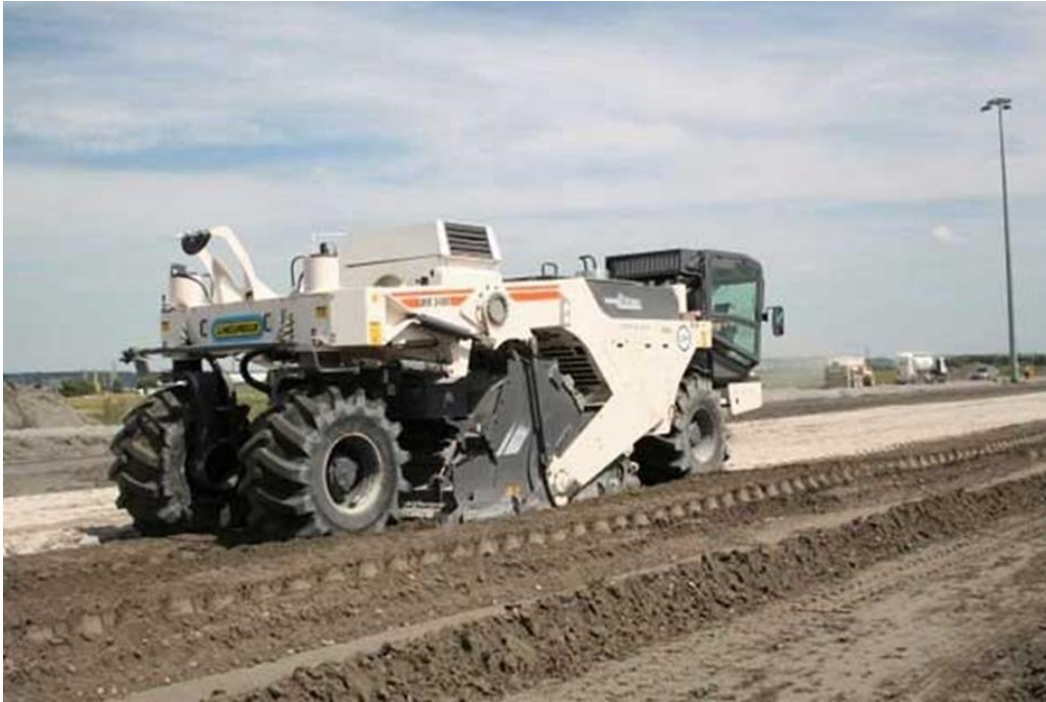
Figure 43 : Malaxage du liant avec le sol
