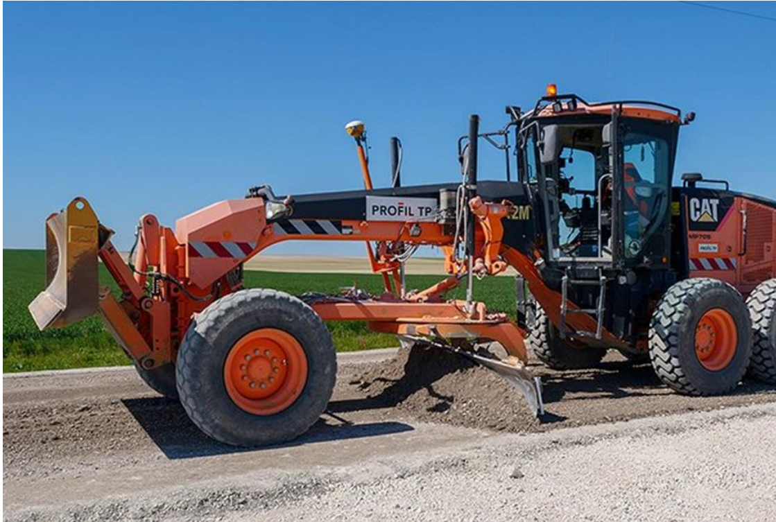
Figure 45 : Réglage d'une couche compactée avec niveleuse
