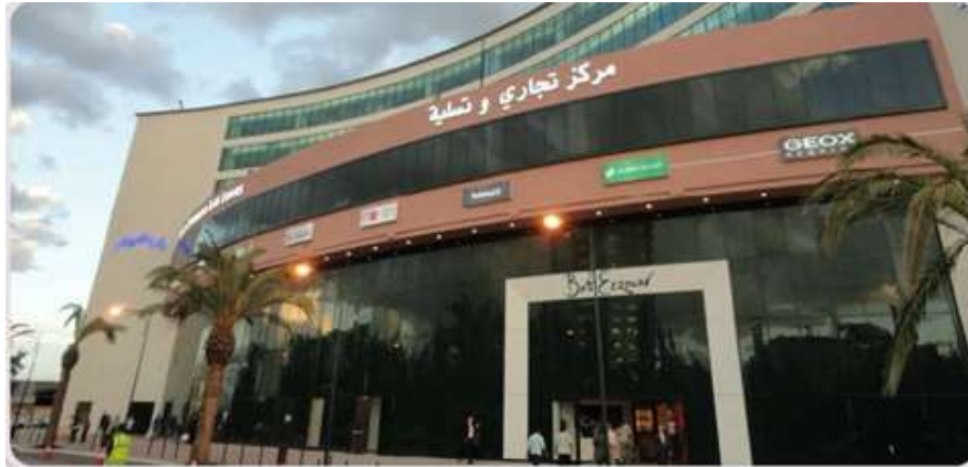
Figure 21 : l'entrée de centre commercial. Source : Google image
