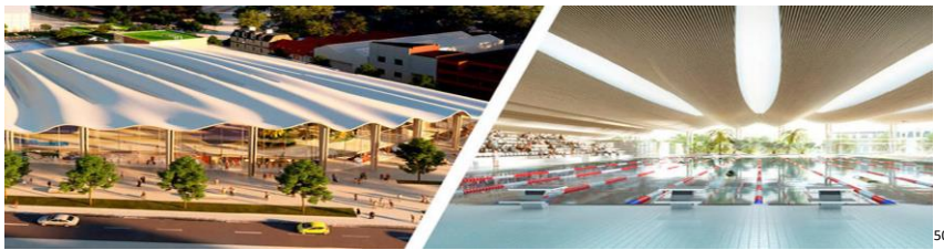
Figure 28 vue sur l'intérieur et l'extérieur du complexe
