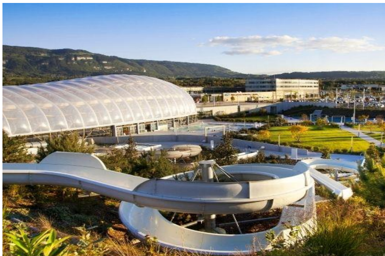
Figure 9 vue aérienne sur laqua parc et ces espace qui les compose
