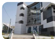
Équipement administrative Direction des fournitures publiques
