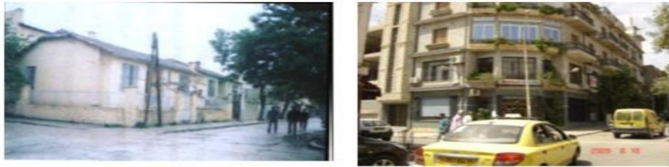
Figure 37 : photo des façades de la maison avant et après son extension
