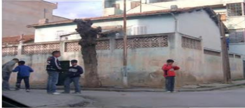
Figure 40 : photo de la façade de l'ancienne maison
