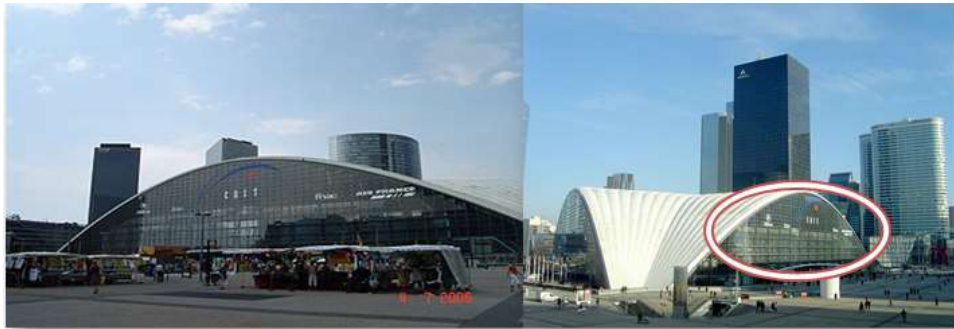
Figure 85 : Façade de CNIT source : le parisien-fr.cdn.ampproject.org.
