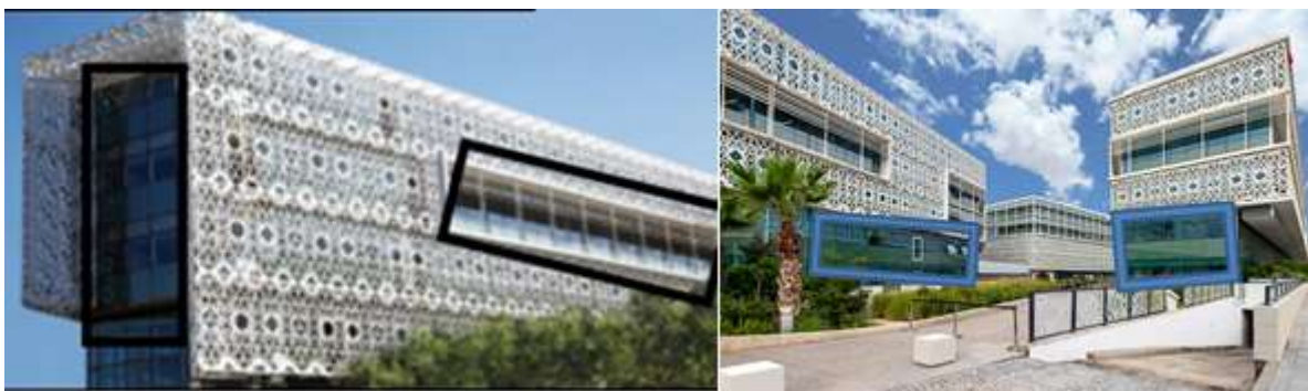
Figure 73 : Façade de CMF
