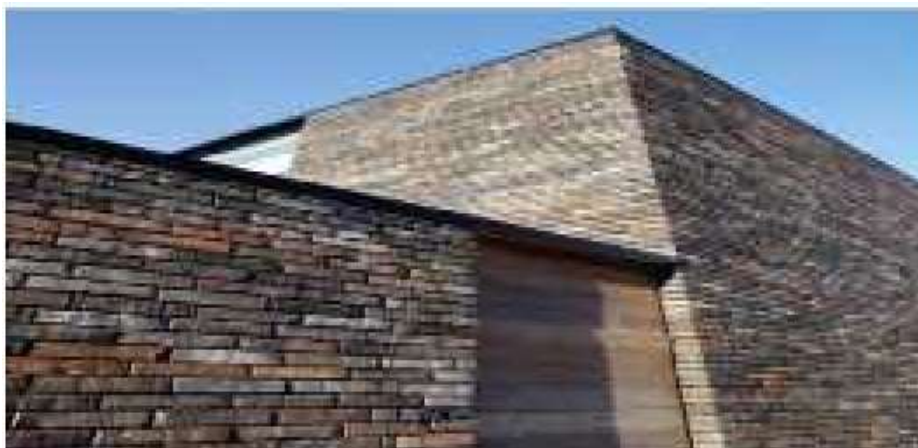
Figure 38 :Figure 38 :appareillage de brique sur façades Figure : crépis rugueux d'une façade (Source : http://kamenchiki.ru/gallery_w_ger.htm ).
