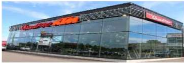
Figure 26 : Enveloppe légère (mur rideau)(Source : http://vitrieriej1.com/produits/murs-rideaux-fenestration ).
