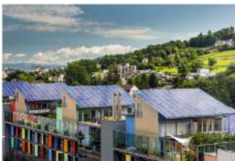
Figure 22 : Logements collectif à énergie positive à Freiburg. Allemagne, source :
