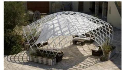
Figure 31 Exemple d'une structure gridshell tridimensionnelle. Source : archdaily.com
