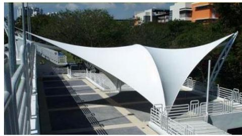
Figure 26 couverture en textile supporté par une structure tendue
