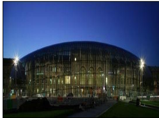
Figure 37 : la nouvelle façade de la gare
