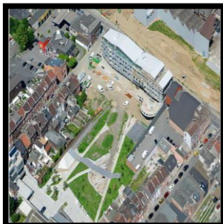
Figure 17 : Le complexe Neocittà - chantier
