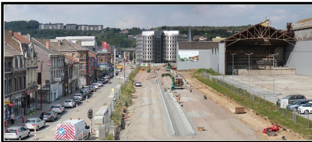
Figure 9 : Elargissement de la Rue Cockerill (état d'avancement des travaux, septembre 2014)
