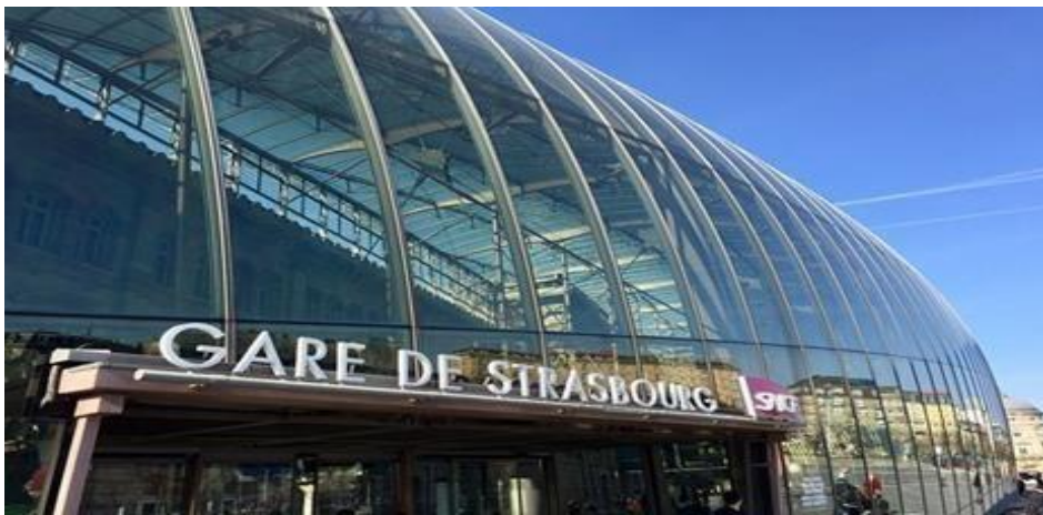
Figure 26: La gare de Strasbourg
