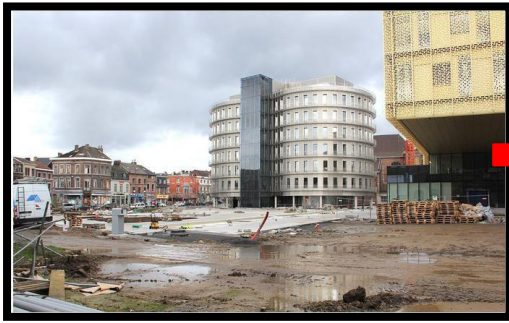
Figure 13 : La Cité administrative-chantier
