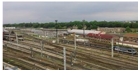
Figure 30: Dépôt de la gare.
