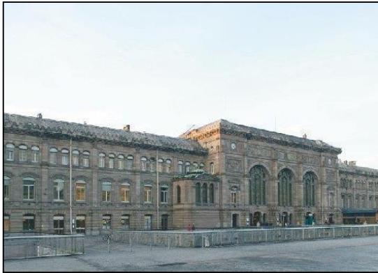
Figure 38: ancienne façade de la gare
