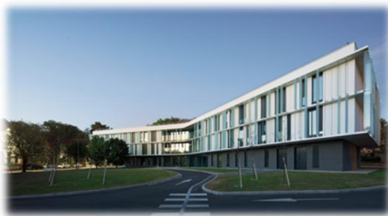
FIGURE 22 : VUE D'EXTERIEUR D'EHPAD DE LA FONDATION ROEDERER
