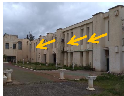
FIGURE 80 : VUE SUR LA COUR INTERIEURE DU PROJET
