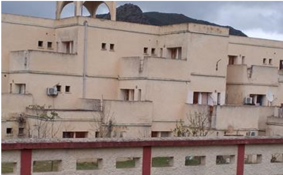
FIGURE 51 :VUE D'EXTERIEUR SUR LES CHAMBRES ET LES BALCONS
