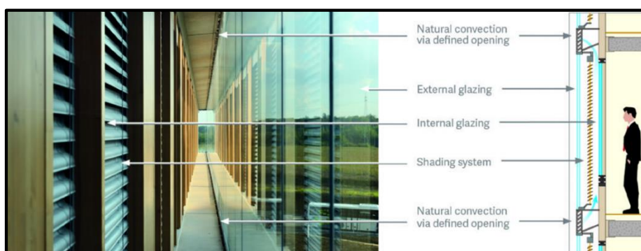
Figure 37: détail de façade double peau, source : https://architectura.be/fr/actualite/37639/facades-double-peau-choisir-la-bonne-combinaison-de-verre-pour-optimiser-leurs-avantages
