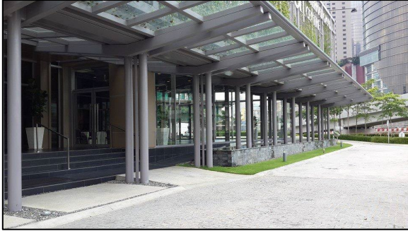
Figure 107 Parois vitrées de la façade avant Source : http://khimmy.smugmug.com/Architecture/
