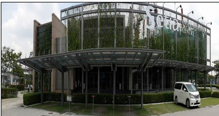
Figure 140 montre l'ombrage végétal installé le long de toute la façade avant du bâtiment, pour garder l'intérieur du bâtiment frais et ombragé. Source: spsetia.com/en-us/property/malaysia-(central)/bangsar/kl-eco-city/home
