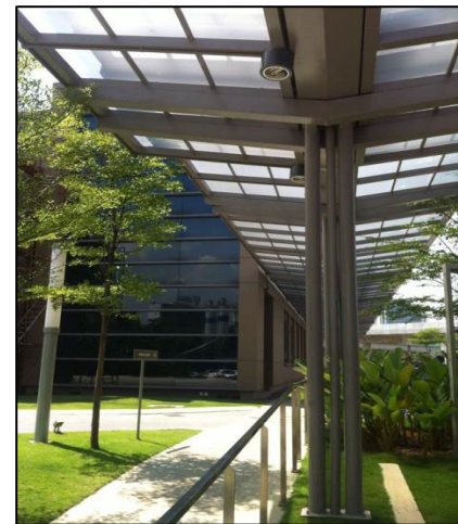
Figure 136 montre des panneaux de polycarbonate ombrageant efficacement le long de la verrière de la passerelle. Source: spsetia.com/en-us/property/malaysia-(central)/bangsar/kl-eco-city/home
