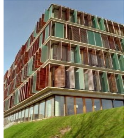
Figure 27 Palmes verticales rotatives: centre de robotique et mécatronique par Birk Heilmeyer und Frenzel Architekten, Weßling, Allemagne Source : https://co.pinterest.com/
