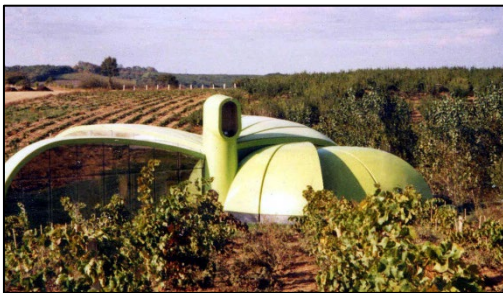
Figure 4 Expérimentation bioclimatique, avec matériaux composite (pierre broyée, fibre de verre et résine) à Crozes-Hermitage, France
