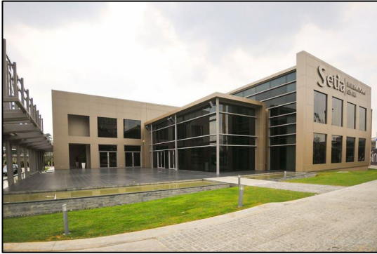
Figure 138 montre le mur-rideau vitré teinté de la façade arrière du bâtiment, ne laissant entrer qu'une certaine quantité de lumière dans le bâtiment Source: spsetia.com/en-us/property/malaysia-(central)/bangsar/kl-eco-city/home
