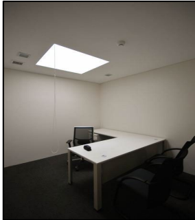
Figure 113 Persiennes réglables manuellement installées sous le puits de lumière Source : http://khimmy.smugmu.com/Architecture/
