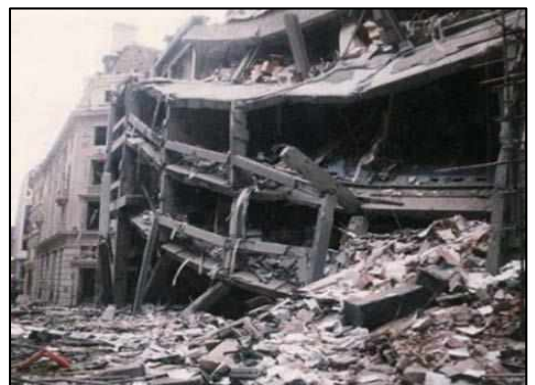
Figure 20 Le bâtiment après l'explosion http://www.skyscrapercity.com
