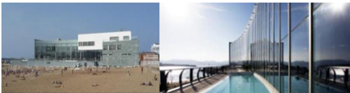
Figure 113: les panneaux solaire de Talasoponiente
