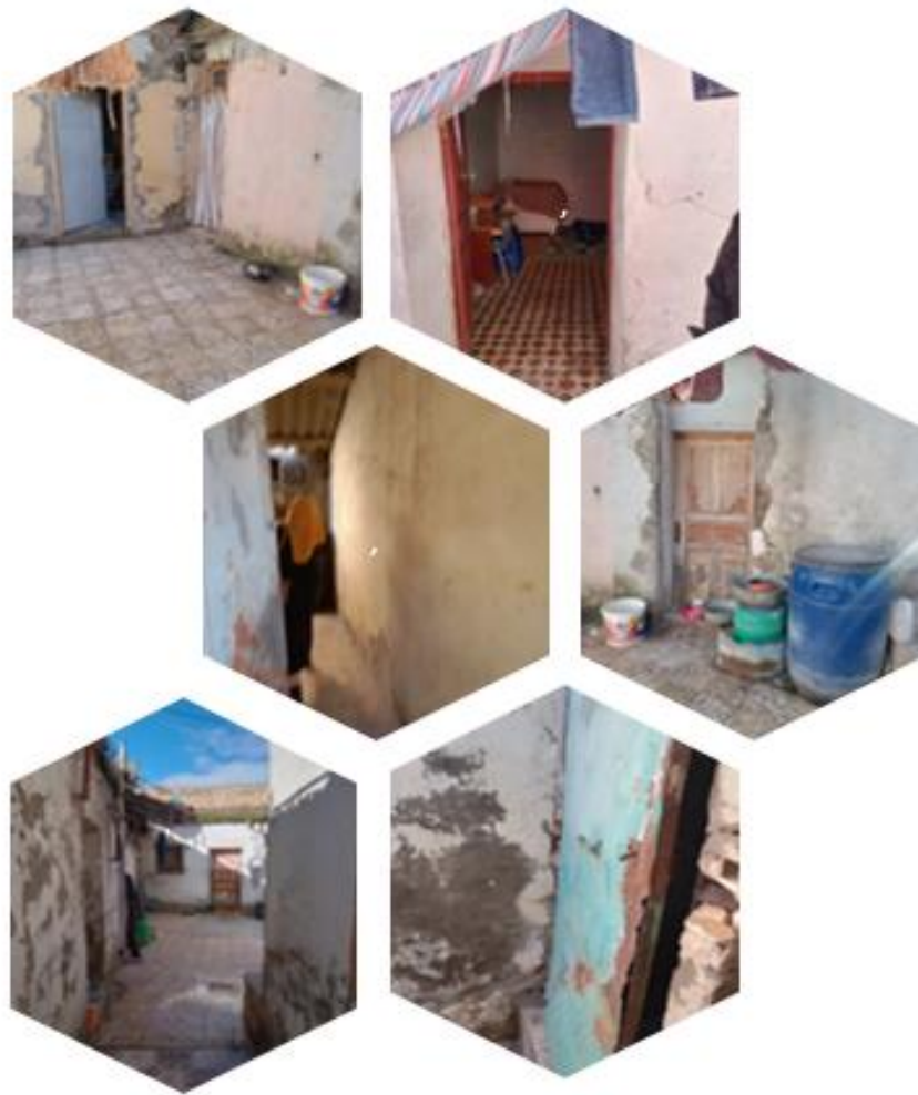
Figure.47 : état de la maison Source : auteure 2021
