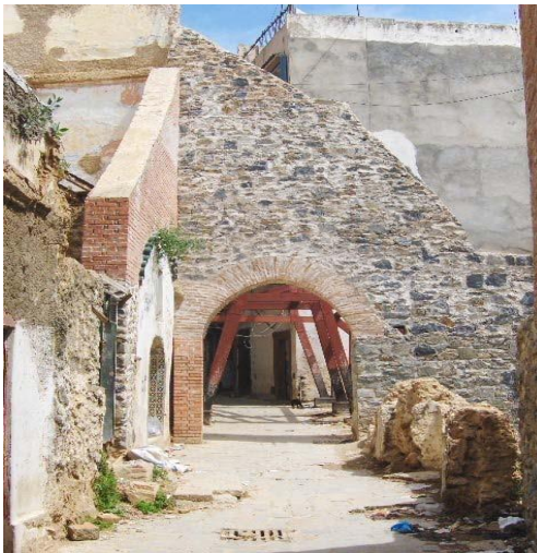
Figure. 35 : Travaux d'étayage intérieur et extérieur des maisons menaçants ruines. Source : CNERU 2007.
