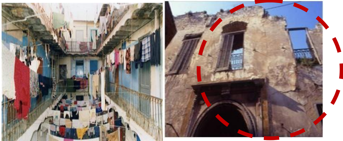
Figure.21 : Le phénomène Ouakala et l'état de dégradation des anciennes habitations traditionnelles. Source : A.S.M 52 .
