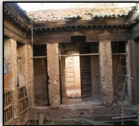
pendant les travaux
