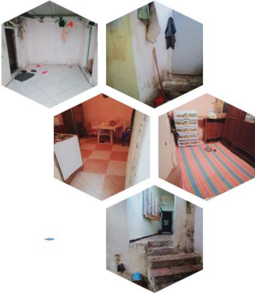
Figure. 71 : etat dr la maison Source auteure 2021
