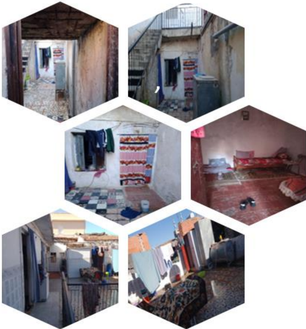
Figure. 66 : ETAT DR LA MAISON SOURCE AUTEURE 2021
