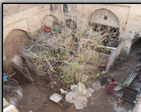
pendant les travaux
