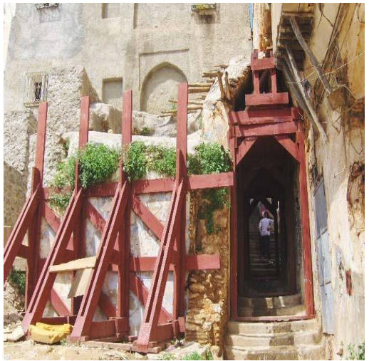
Figure. 35 : Travaux d'étayage intérieur et extérieur des maisons menaçants ruines. Source : CNERU 2007.
