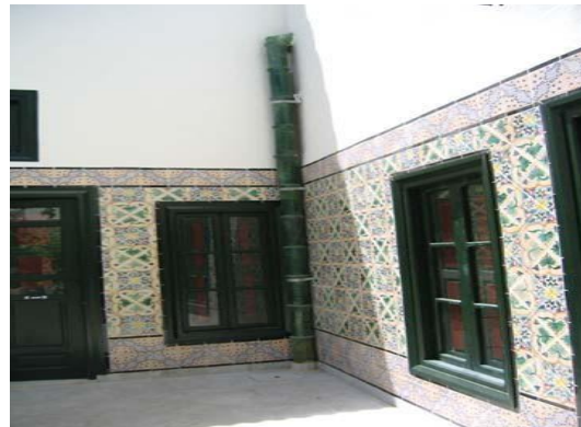
Figure.26 : L'exemple de restauration et de reconversion de Dar El Bahri –Tunis, dans le cadre du projet Oukala. Source : A.S.M.
