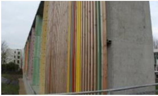
Figure 125: façade en béton de CASEO
