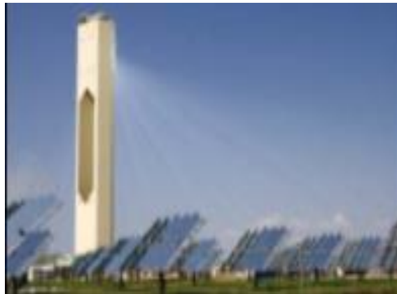
Figure 39: Le central à tour.
