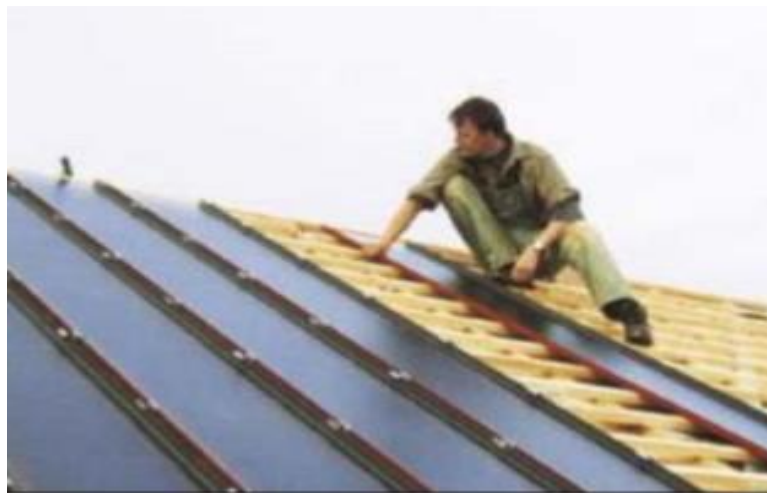
Figure 46 : Intégration des capteurs en toiture incliné.
