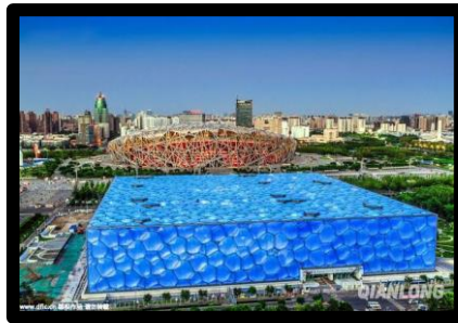
Figure 132: le centre aquatique le Cube d'eau
