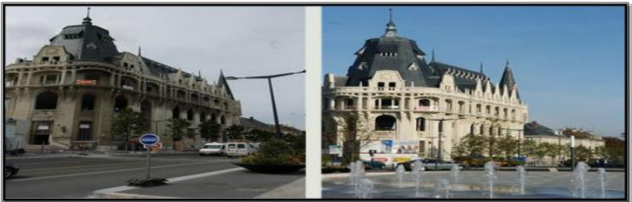
Figure 2: Ancien hôtel du post transforme en médiathèque. Source (introduction à l'urbanisme opérationnel p : 304).
