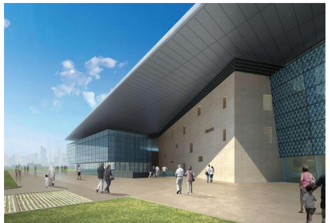
Figure 55 : Vue sur la façade ouest Source : http://www.archello.com/en/project/zenith
