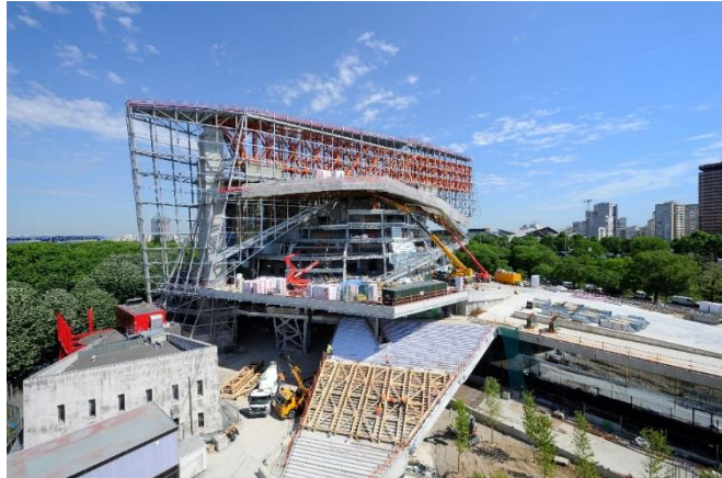
Figure 61 : vue extérieur de la structure de philharmonie Source : https://www.lafarge.fr/un-nouveau-batiment-pour-la-philharmonie-de-paris
