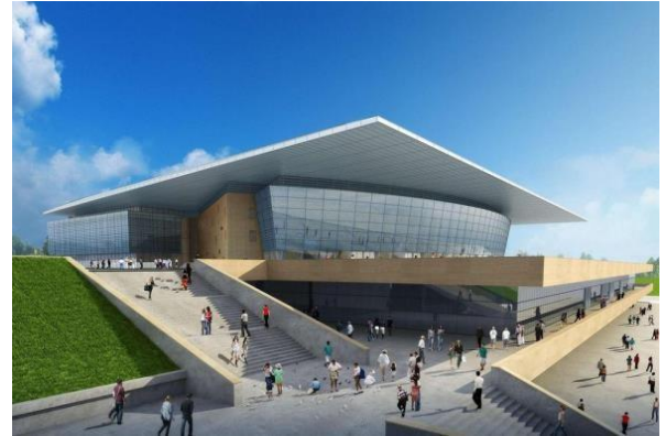
Figure 89 : zénith de Constantine sa couverture d'aluminium en pente Source : http://www.archello.com/en/project/zenith
