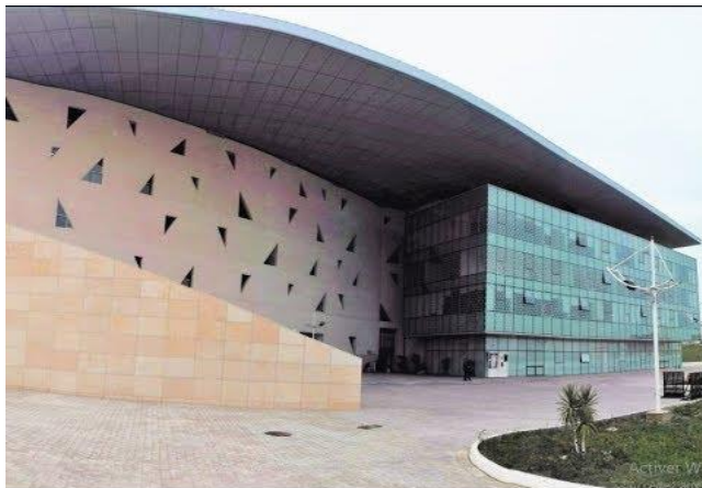
Figure 54 : Vue sur la façade nord-est Source: NEW PROJECTS IN ALGERIA. Le zenith de CONSTANTINE
