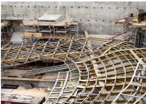
Figure 75 : Structure neuf poutres-caissons en béton de la salle Source : https://www.lemoniteur.fr/photo/philharmonie-paris.842649/9-philharmonie-paris.9
