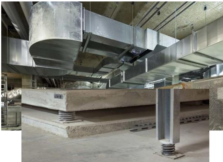
Figure 78 : Les gaines et le semelles isolées du sol par des boîtes à ressorts Source : https://www.lemoniteur.fr
