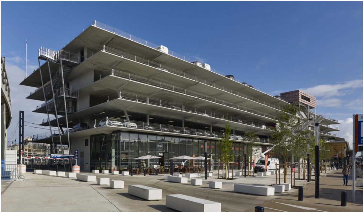
Figure 19 : Gare Bordeaux Saint-Jean Belcier Source : https://structurae.net/fr/ouvrages/gare-bordeaux-saint-jean-belcier
