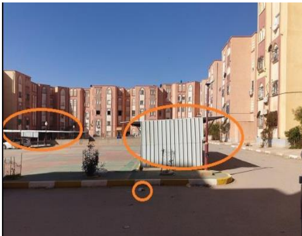
Fig n°5: Espace de stationnement Cité 256 logts LSP, Oasis Nord
