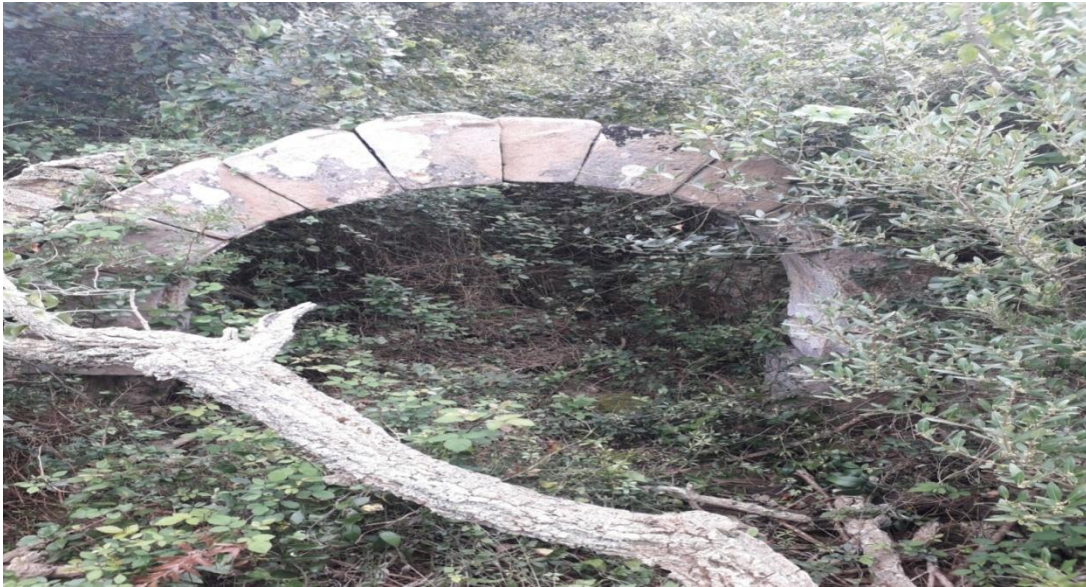
الصورة رقم 19 توضح القسم الارضي للقصر
