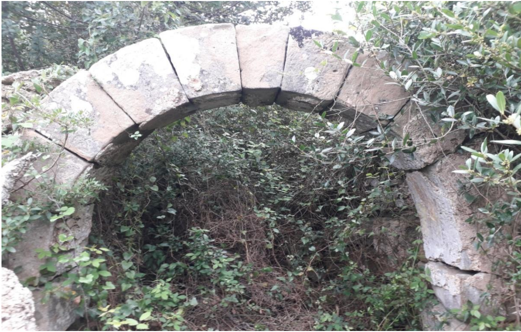
الصورة رقم 18: توضح القسم الارضي للقصر
