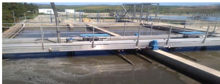
Figure14: Bassin du déshuilage de la STEP de Guelma (Azzedine, A.K., 2016).
