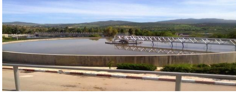
Figure15: Bassin du décanteur primaire (Azzedine, A.K., 2016).
