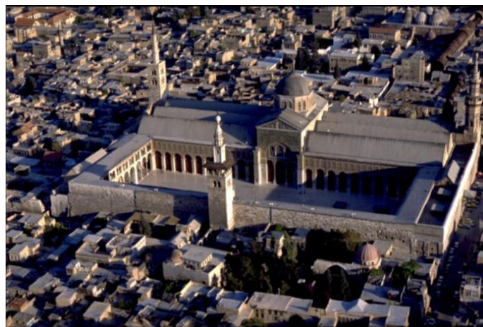
Figure 5-7 : La grande Mosquée de Omeyade à Damas : Aspect extérieur
