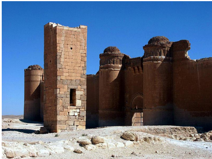
Figure 5-9: Photographie du palais du désert: Qasr El Hayr Echarqi
