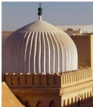
Figure 3-8 : Dôme à cannelures de la grande mosquée de Kairouan
