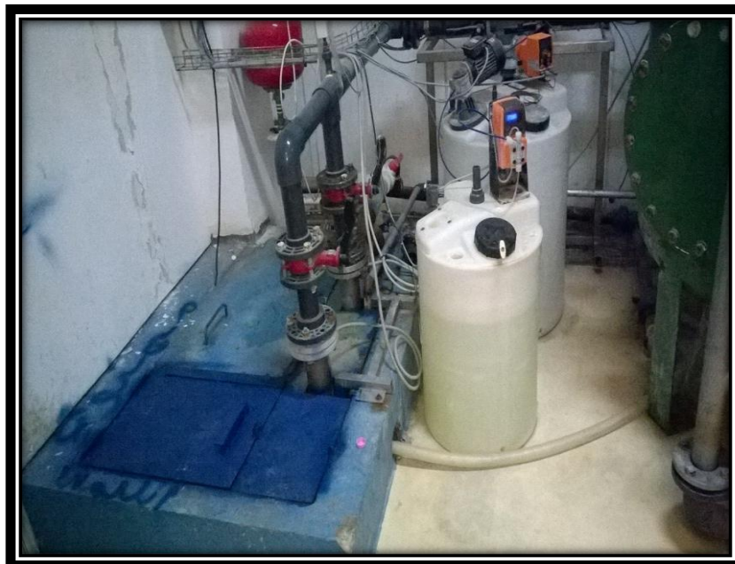
Figure 13 : réservoir d’eau du groupe Benamor (Source : NAILI .A & MENIDJEL .Y 2018)
