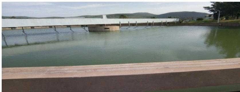
**Fig. II.8.** Décanteur raclé à ciel ouvert
