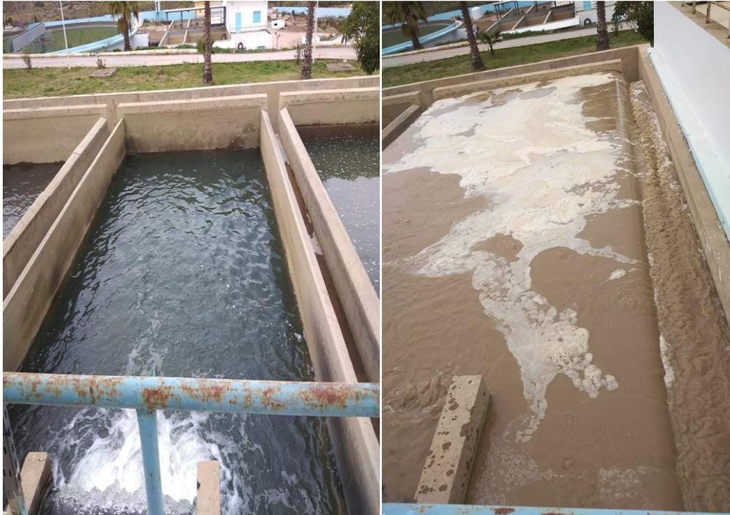
**Figure II.9** : Filtre après (gauche) et avant (droite) lavage
