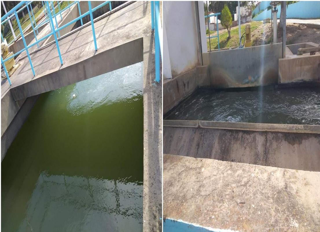
Figure II.7 : Bassin de coagulation-floculation
