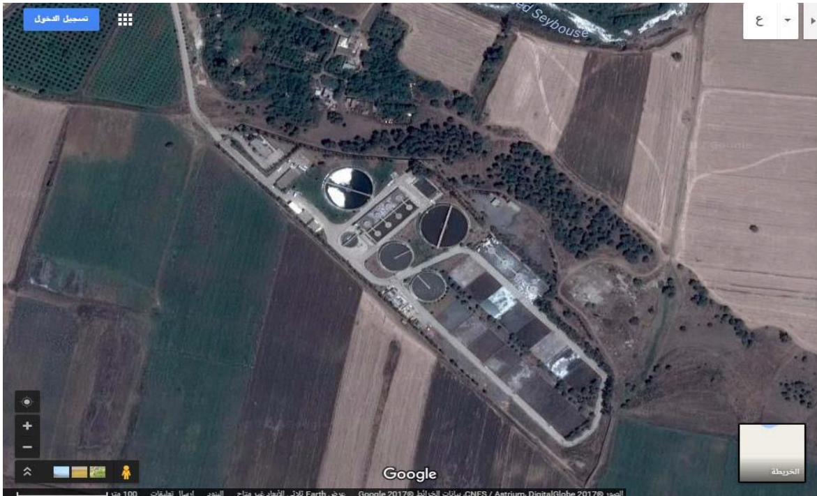
Figure II.1 : Photo aérienne de la station d'épuration (Guelma 2017).
