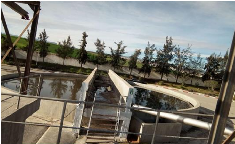
Figure II. 9 : Epaisseur des boues.
