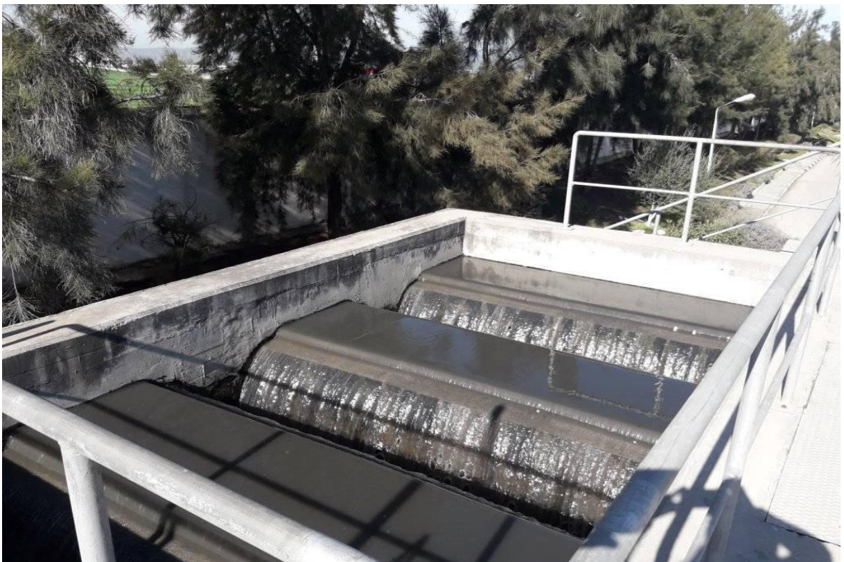
Figure II.4: Dessablage et déshuilage
