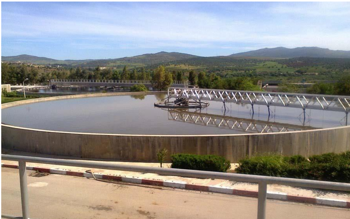
Figure II.5 : décanteur primaire (STEP Guelma 2017).
