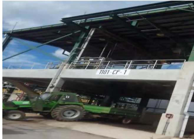
Figure II.12: Séchage des boues produites par le traitement chimique et biologique. 1101-CF-1
