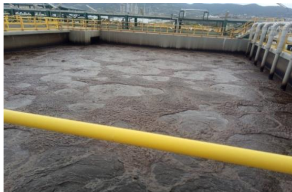
Figure III.11 : Bassin aéré par diffusion d'air
