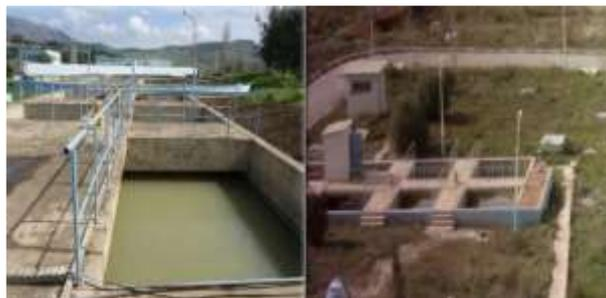
Figure II.1: Bassin de mélange (pré chloration)
