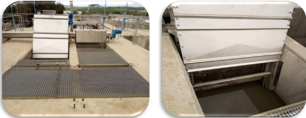
Photo 01 : Le dégrillage (photo prise par Merzoug Khawla).
