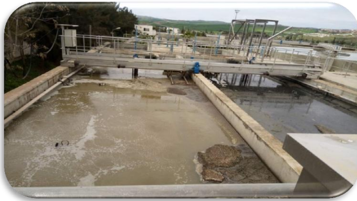
Photo 02 : Dessablage et Déshuilage (photo prise par Benabassa Marwa).
