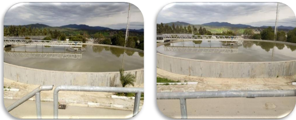
Photo 03 : Bassin de décantation primaire (photo prise par Merzoug Khawla).
