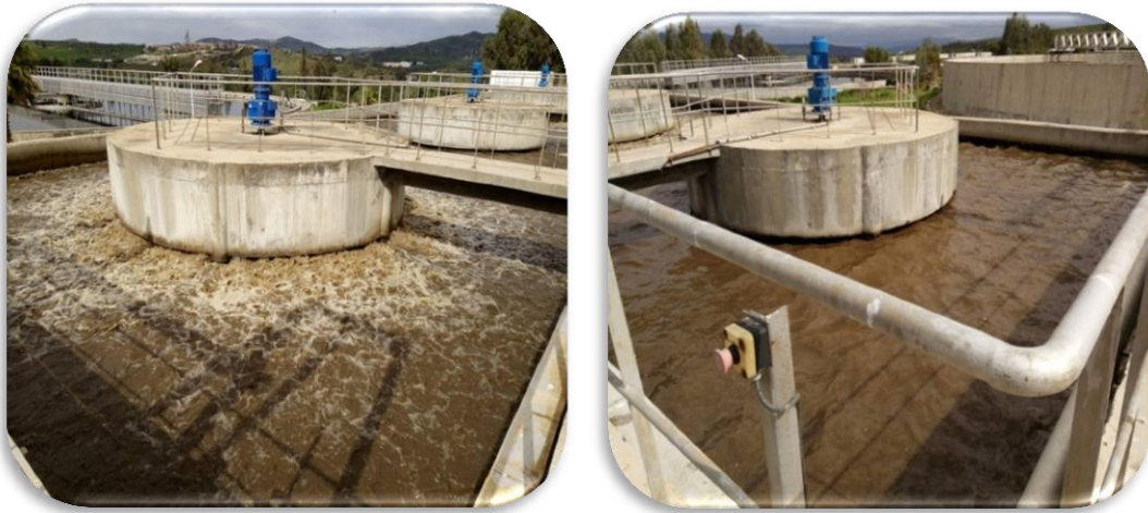
Photo 04 : Bassin d'aération biologique (photo prise par Benabassa Marwa).
