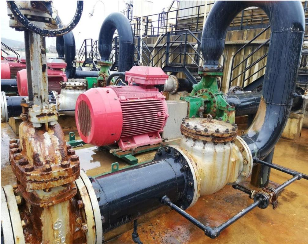
Figure III.1: Pompe centrifuge 502-P- 001A
