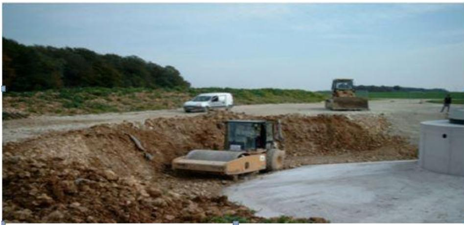
Figure II.1 Travaux de réalisation d'un remblai [1]
