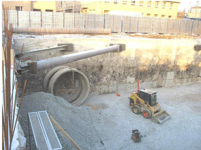
**Figure I.15** Construction de paroi moulée avec butons [11]
