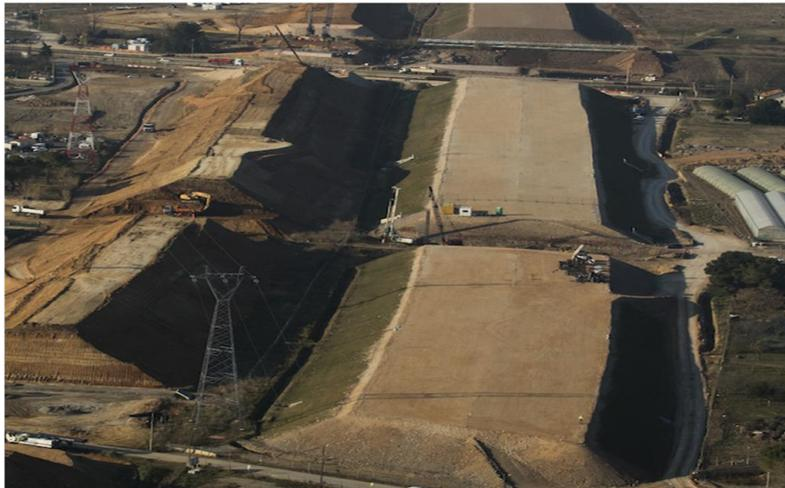
**Figure II.9** Remblai de grande hauteur [2]
