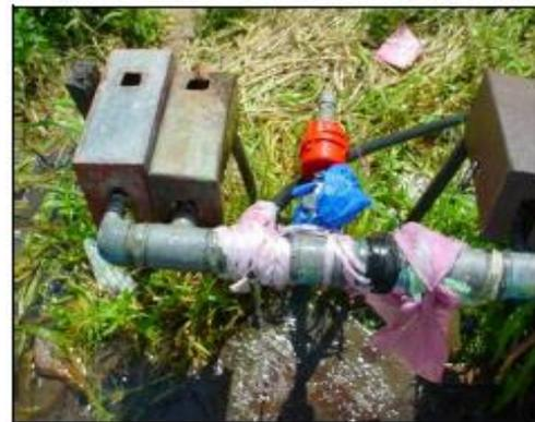
Figure III-3 : Les pertes apparentes
