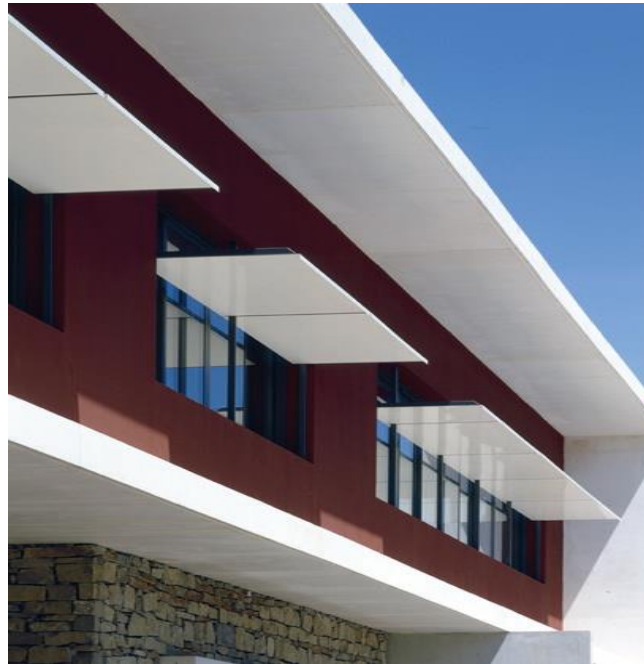
Figure .I.4 : Le lycée Jean-Jaurès près de Montpellier. [1]
