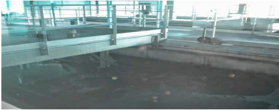
Figure .IV.5 : Schéma d'un déshuileur-dégraisseur.
