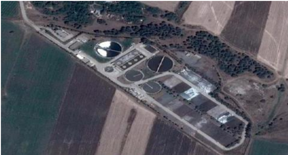
Figure.V.3 : Photo aérienne de la station d'épuration (Guelma). [26]
