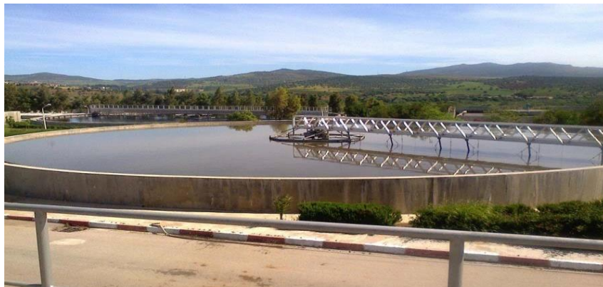
Figure.V.6 : Décanteur primaire (STEP Guelma). [26]
