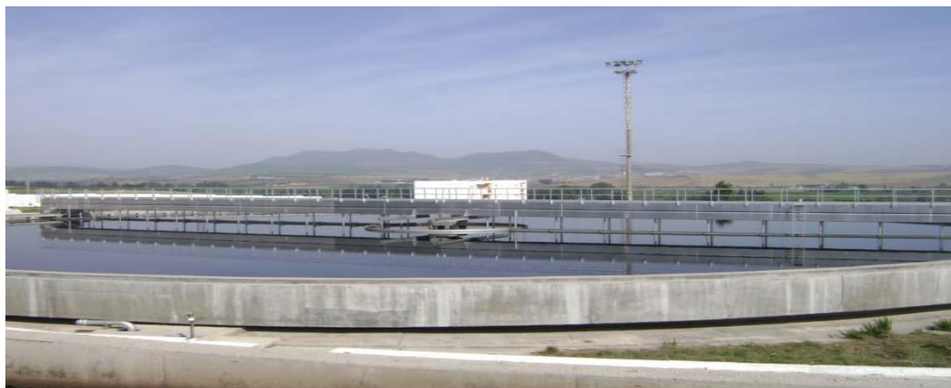
Figure.V.8 : Clarificateur (STEP Guelma). [26]
