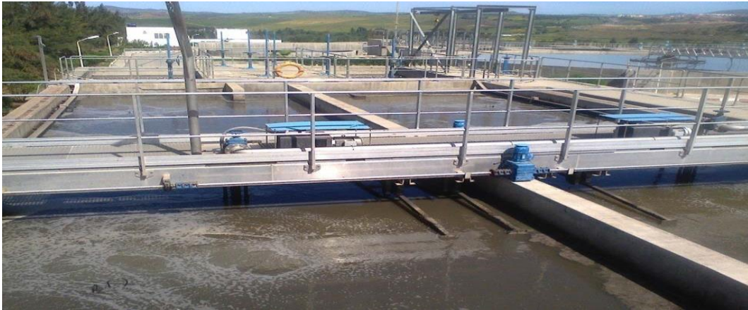
Figure.V.5 : Dessablage – Déshuilage (STEP Guelma). [26]
